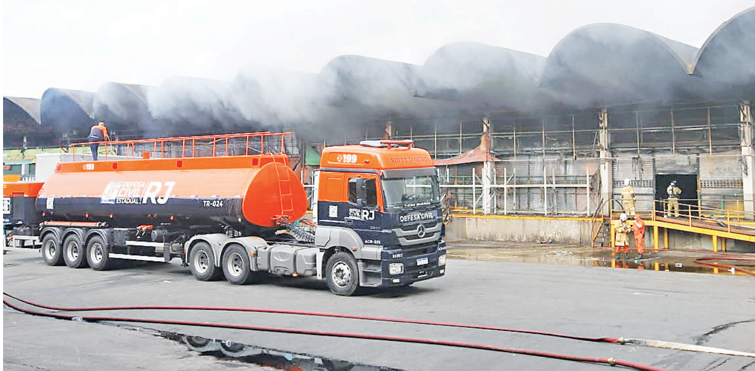
Bombeiros combateram incêndio que atingiu cerca de 28 lojas na Ceasa, em Irajá. Alguns estabelecimentos ficaram totalmente destruídos
