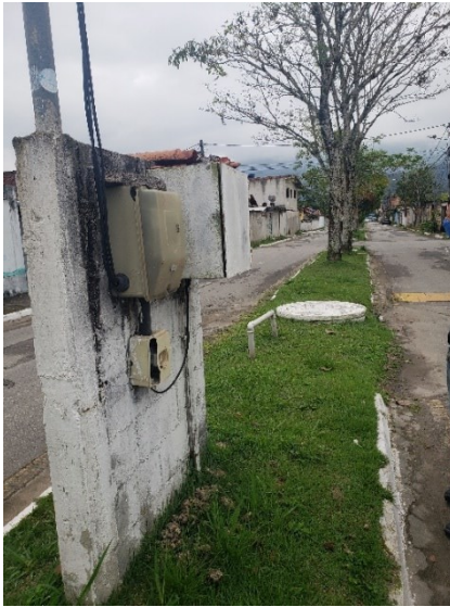
FIGURA 6-36 – EEE 03 – VISTA GERAL
