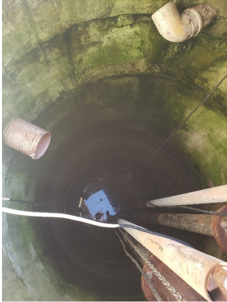
FIGURA 6-205 – ETE PROVETÁ – EEE
