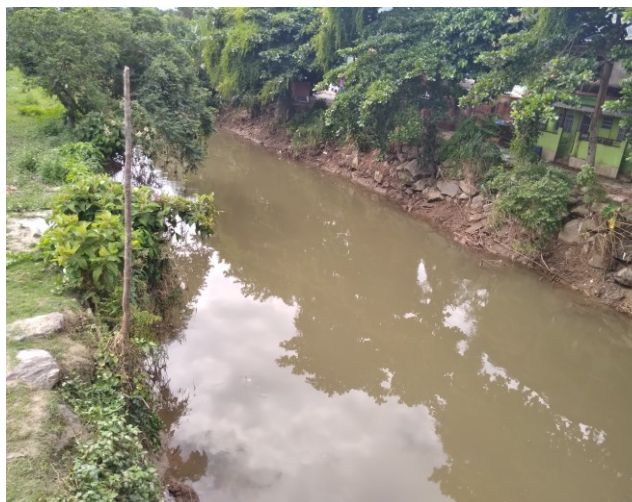
FIGURA 7-19 – VISTA DO CANAL DO RIO DO MEIO
