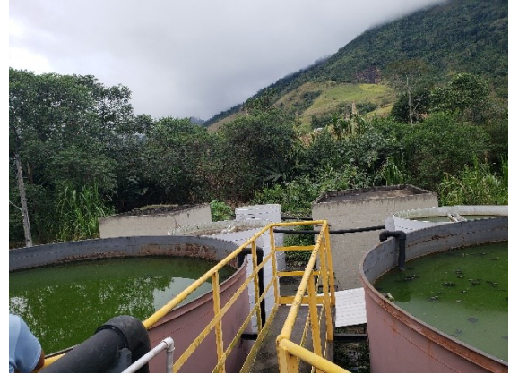
FIGURA 6-71 – VISTA SUPERIOR DOS TANQUES DE AERAÇÃO E DECANTADORES
