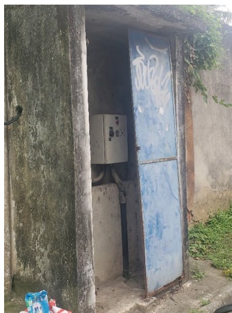
FIGURA 6-82 – EEE ALVORADA – ABRIGO DE QUADRO ELÉTRICO
