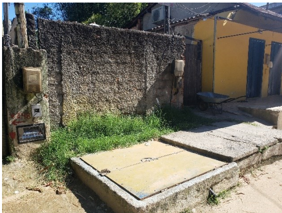
FIGURA 6-188 – EEE 04 – VISTA GERAL
