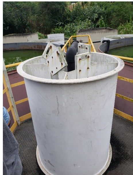
FIGURA 6-73 – CAIXA DE DISTRIBUIÇÃO DOS TANQUES DE AERAÇÃO
