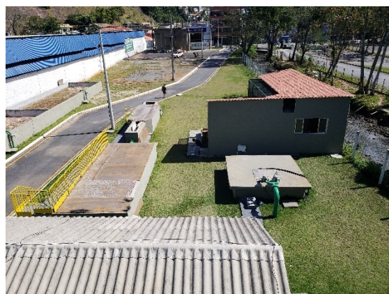
FIGURA 6-120 – ETE PRAIA DA CHÁCARA – VISTA GERAL DO TRATAMENTO PRELIMINAR E EEE
