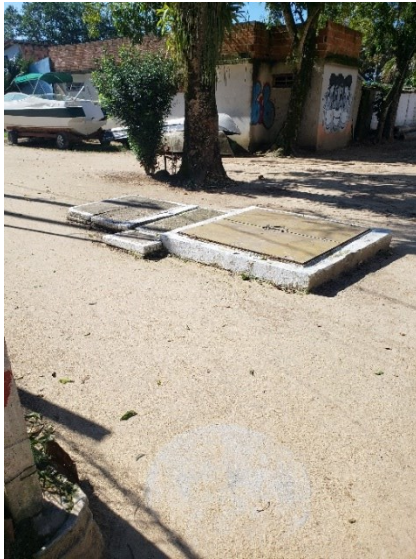
FIGURA 6-194 – EEE 02 – VISTA GERAL
