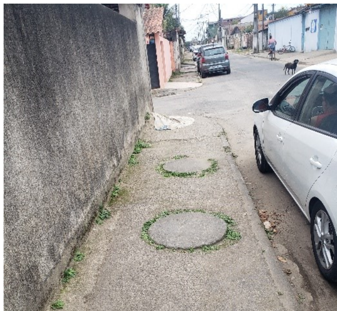
FIGURA 6-25 – SISTEMA FOSSA, FILTRO E SUMIDOURO
