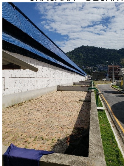
FIGURA 6-130 – ETE PRAIA DA CHÁCARA – LEITOS DE SECAGEM
