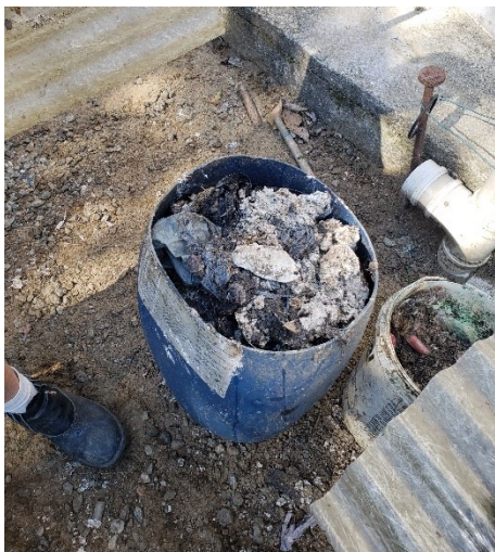
FIGURA 6-153 – ETE VILA VELHA – ESCUMA REMOVIDA DA EEE
