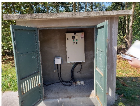
FIGURA 6-119 – EEE HOTEL – QUADRO ELÉTRICO
