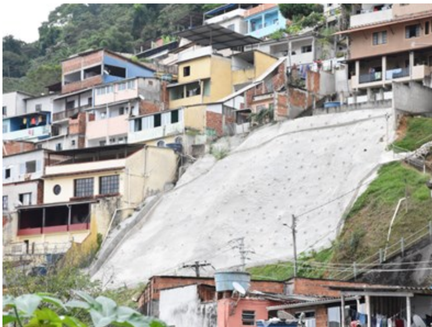
FIGURA 7-3 – OBRA DE CONTENÇÃO DE ENCOSTA NO MORRO DA GLÓRIA I Fonte: Prefeitura Municipal de Angra dos Reis, 2022
