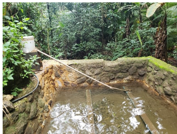
FIGURA 5-67 – BARRAGEM DE ACUMULAÇÃO DO SAA NOVA BELÉM
