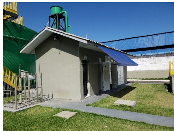
FIGURA 6-132 – ETE PRAIA DA CHÁCARA – CASA DE APOIO
