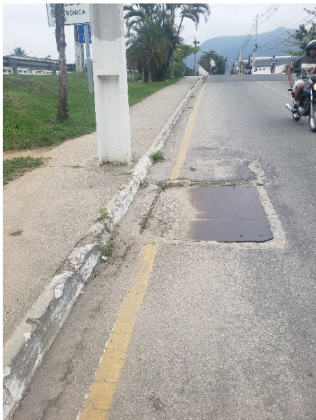
FIGURA 6-83 – EEE AREAL – VISTA GERAL
