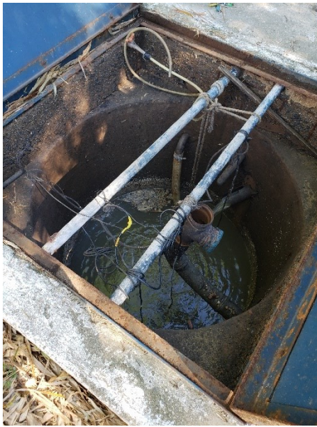
FIGURA 6-186 – EEE 05 – POÇO DE SUCÇÃO
