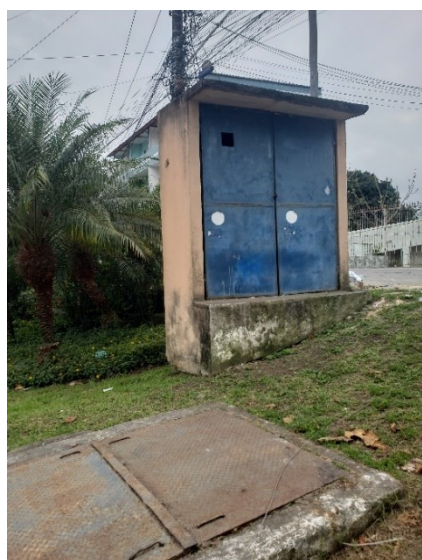
FIGURA 6-89 – EEE JAPUÍBA – VISTA GERAL
