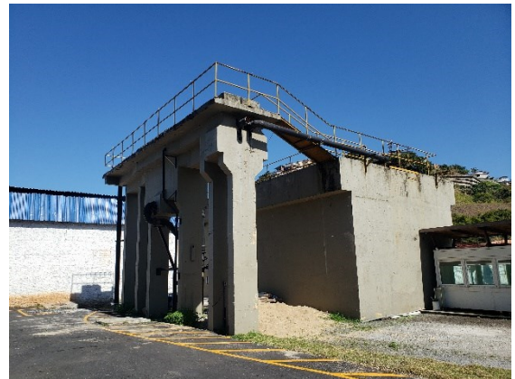
FIGURA 6-111 – VISTA GERAL DO RAFA
