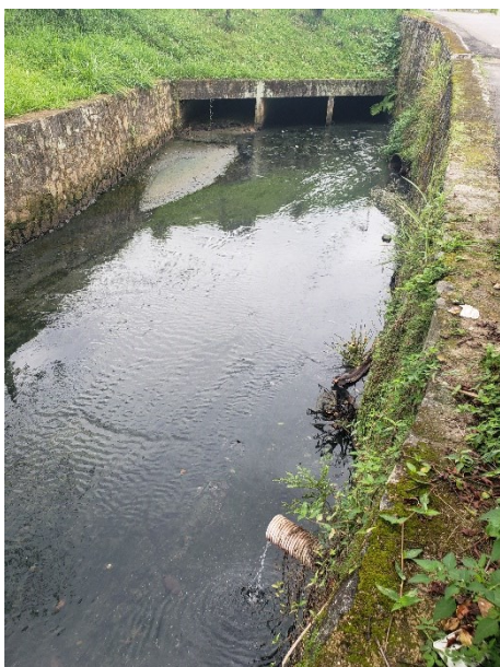
FIGURA 6-51 – ETE RAIMUNDO CAPRIANO – EXTRAVASSOR LANÇANDO EM CANAL DE DRENAGEM
