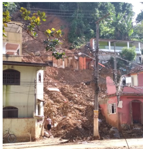
FIGURA 7-9 – DESLIZAMENTO EM ÁREA RESIDENCIAL EM MOSUABA
