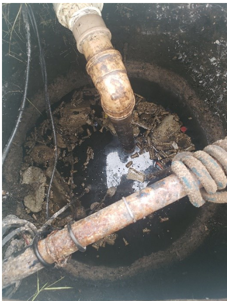
FIGURA 6-40 – EEE 04 – POÇO DE SUCÇÃO
