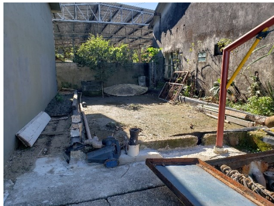
FIGURA 6-201 – ETE ABRAÃO – LEITO DE SECAGEM
