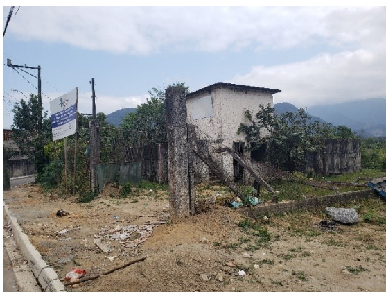
FIGURA 6-18 – ETE PARQUE MAMBUCABA – VISTA GERAL
