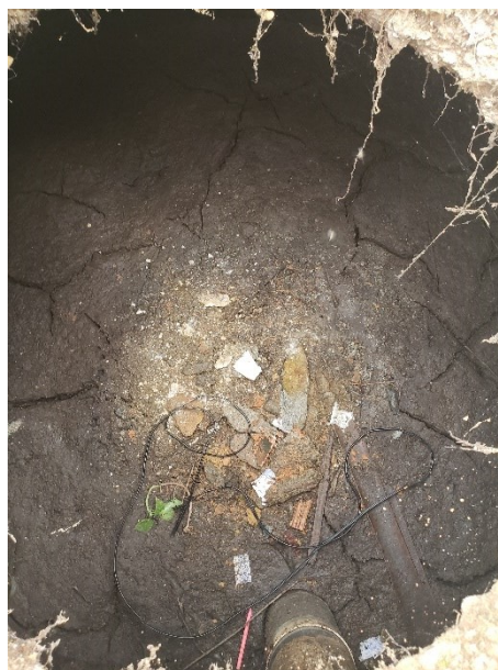
FIGURA 6-33 – VISTA INTERNA DA FOSSA
