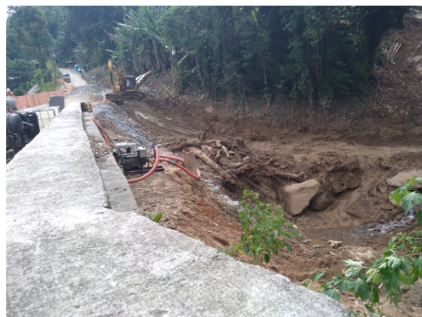
FIGURA 7-13 – OBRAS DE RECUPERAÇÃO DA ESTRADA PARA PONTA LESTE (REALIZADA PELA PETROBRÁS)
