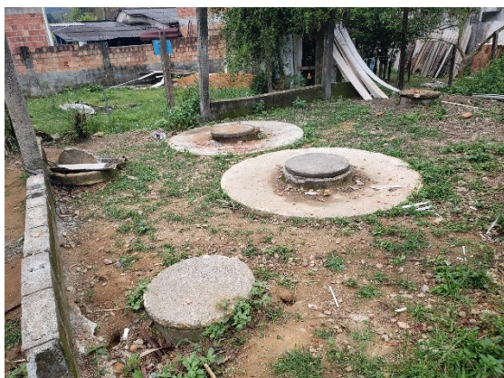
FIGURA 6-32 – SISTEMA FOSSA, FILTRO, SUMIDOURO
