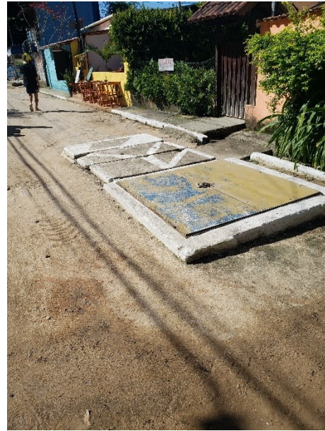
FIGURA 6-191 – EEE 03 – VISTA GERAL
