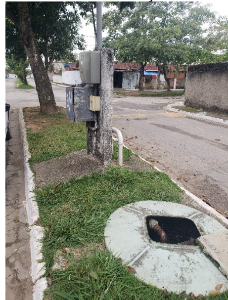
FIGURA 6-39 – EEE 04 – VISTA GERAL
