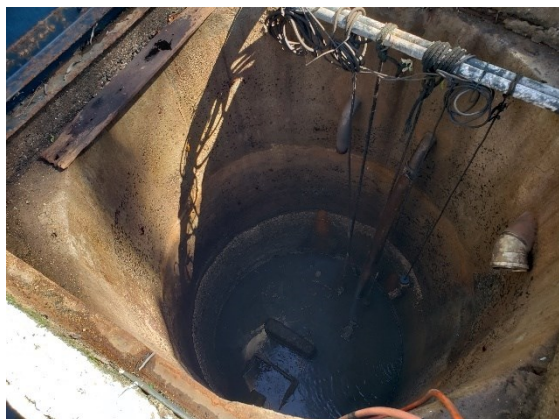
FIGURA 6-184 – EEE 06 – POÇO DE SUCÇÃO
