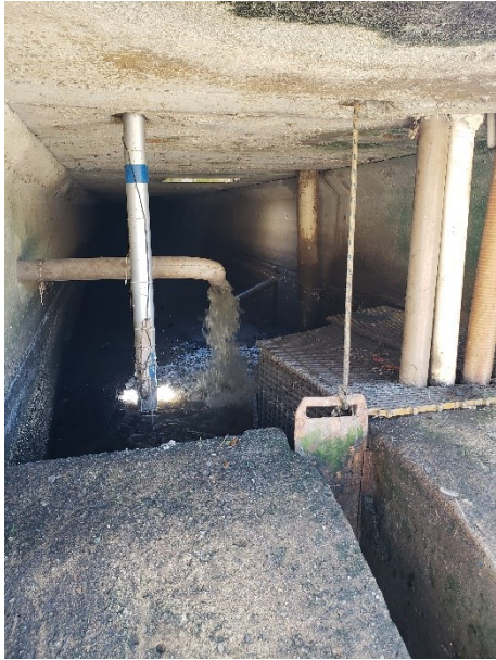
FIGURA 6-108 – EEE ANIL - POÇO DE SUCÇÃO COM GRADEAMETNO
