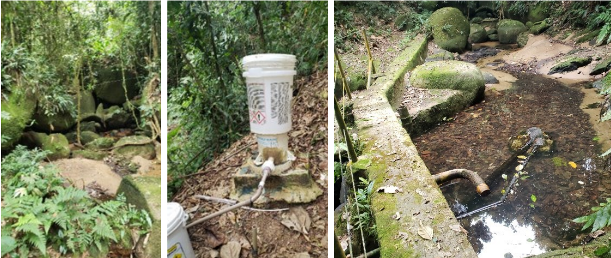
FIGURA 5-24 – BARRAGEM DE ACUMULAÇÃO DO SUBSISTEMA BARLAVENTO
