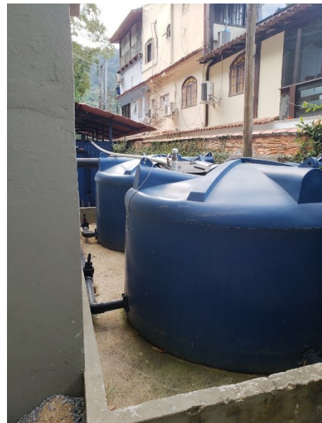
FIGURA 6-138 – ETE – TANQUES DE EQUALIZAÇÃO
