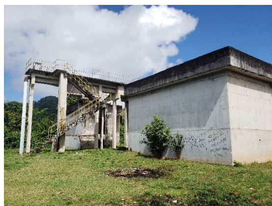
FIGURA 6-90 – ETE JAPUÍBA – VISTA GERAL
