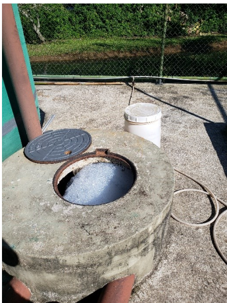
FIGURA 6-209 – ETE PROVETÁ – EFLUENTE FINAL
