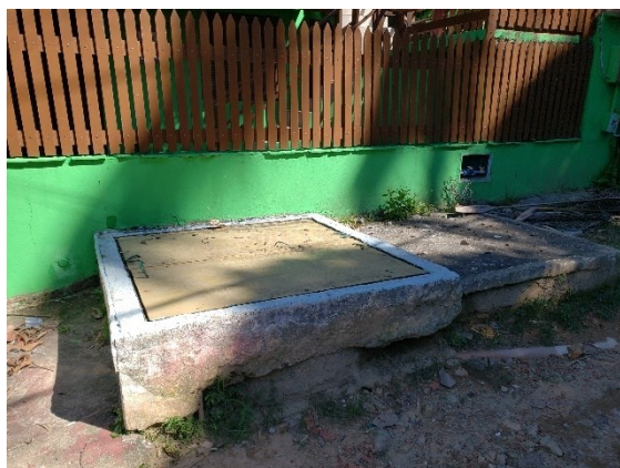
FIGURA 6-182 – EEE 06 – VISTA GERAL
