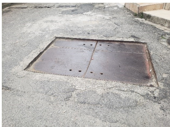
FIGURA 6-85 – EEE MACAÉ – VISTA GERAL
