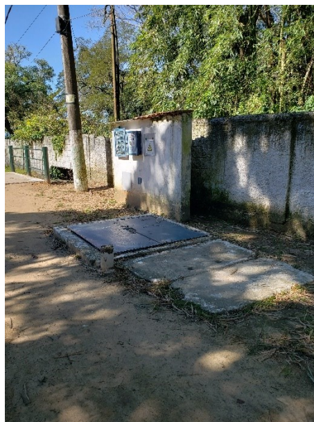
FIGURA 6-185 – EEE 05 – VISTA GERAL
