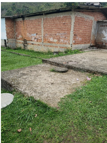
FIGURA 6-58 – SISTEMA FOSSA SÉPTICA E FILTRO ANAERÓBIO
