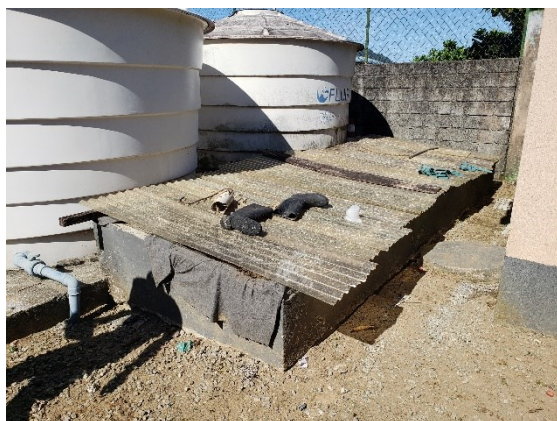
FIGURA 6-155 – ETE VILA VELHA – LEITOS DE SECAGEM
