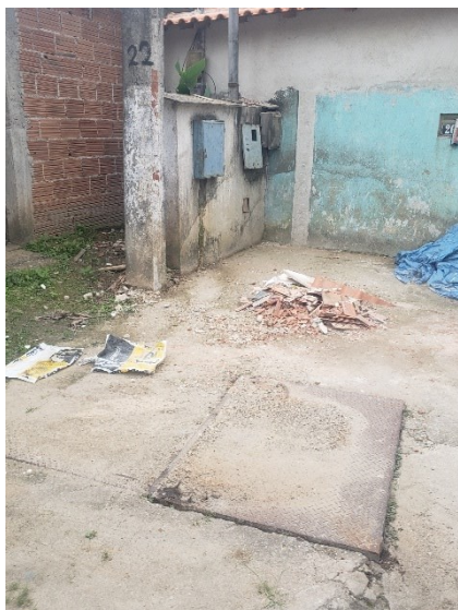
FIGURA 6-79 – EEE PALMIRA – VISTA GERAL
