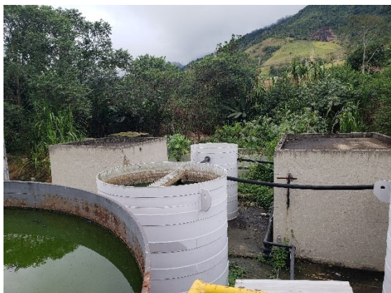
FIGURA 6-74 –DECANTADORES
