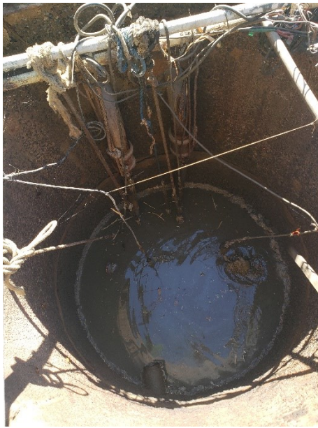
FIGURA 6-190 – EEE 04 – POÇO DE SUCÇÃO
