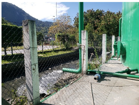
FIGURA 6-129 – ETE PRAIA DA CHÁCARA – LANÇAMENTO FINAL
