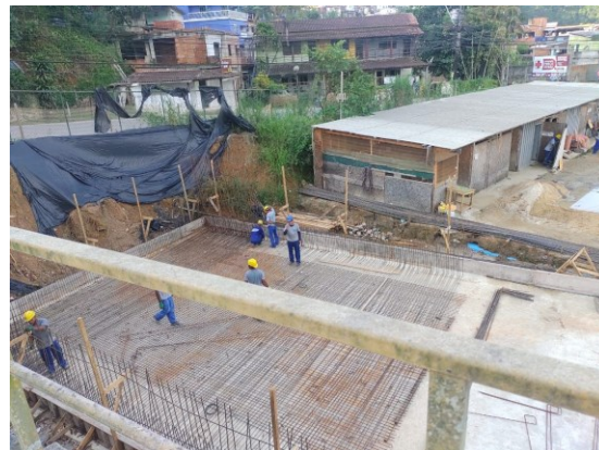
FIGURA 6-173 – OBRAS DE AMPLIAÇÃO – ETE MONSUABA
