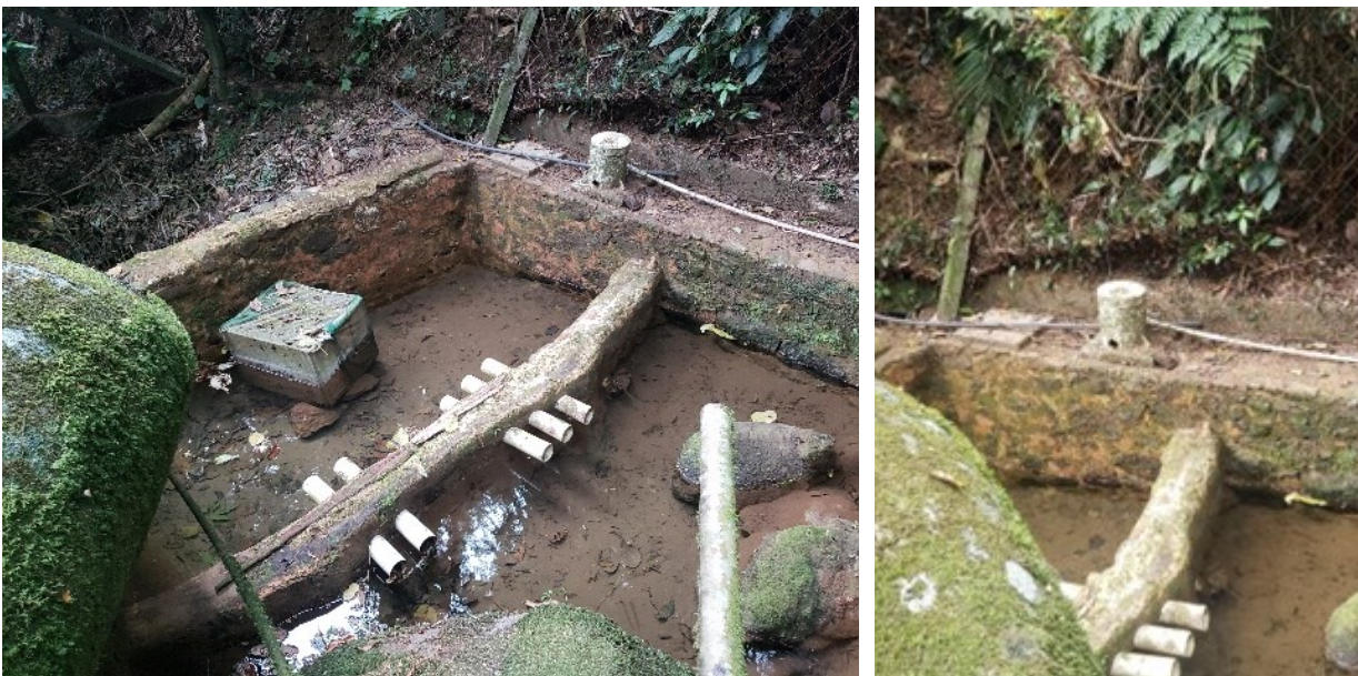
FIGURA 5-22 – BARRAGEM DE ACUMULAÇÃO DO SUBSISTEMA PRAIA VERMELHA
