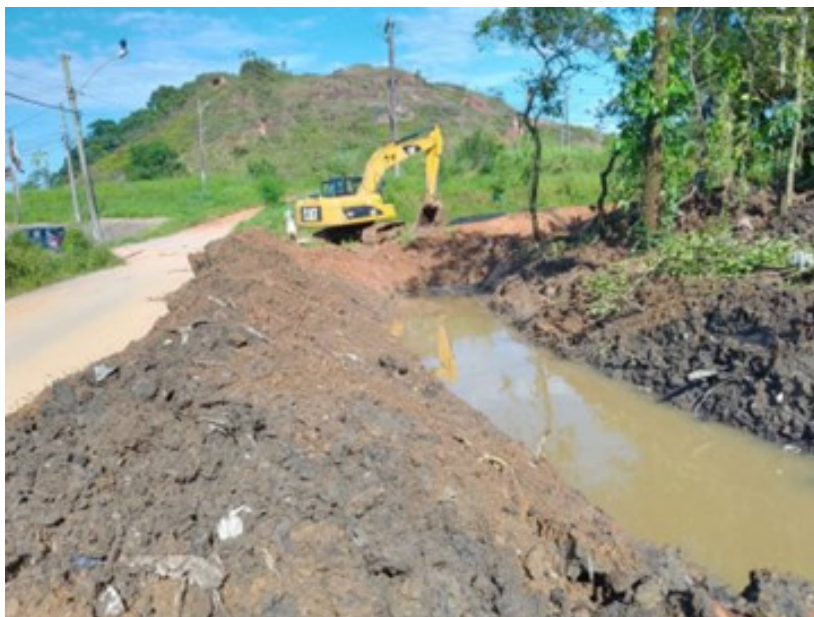
FIGURA 7-2 – DESASSOREAMENTO DE CURSO D'ÁGUA NO BAIRRO BELÉM Fonte: Prefeitura Municipal de Angra dos Reis, 2022
