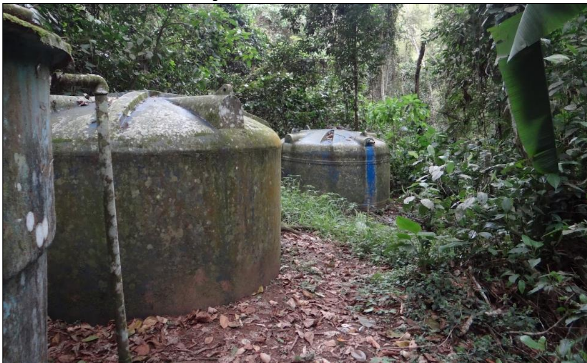
Figura 49 - Reservatório Vila Velha
