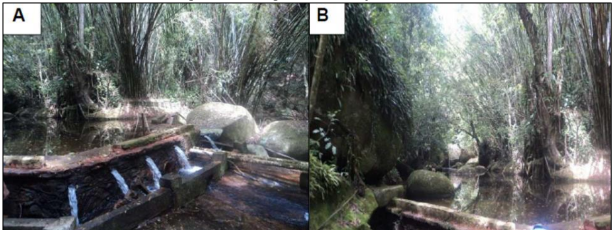
A: Tubulação de saída da barragem; B: Vista do entorno.
