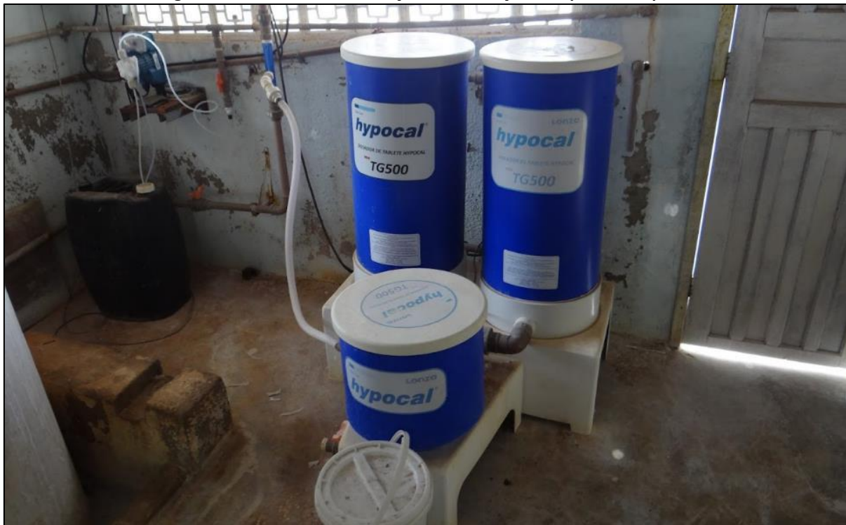
Figura 66- Sistema de desinfecção e fluoretação Complexo Banqueta
