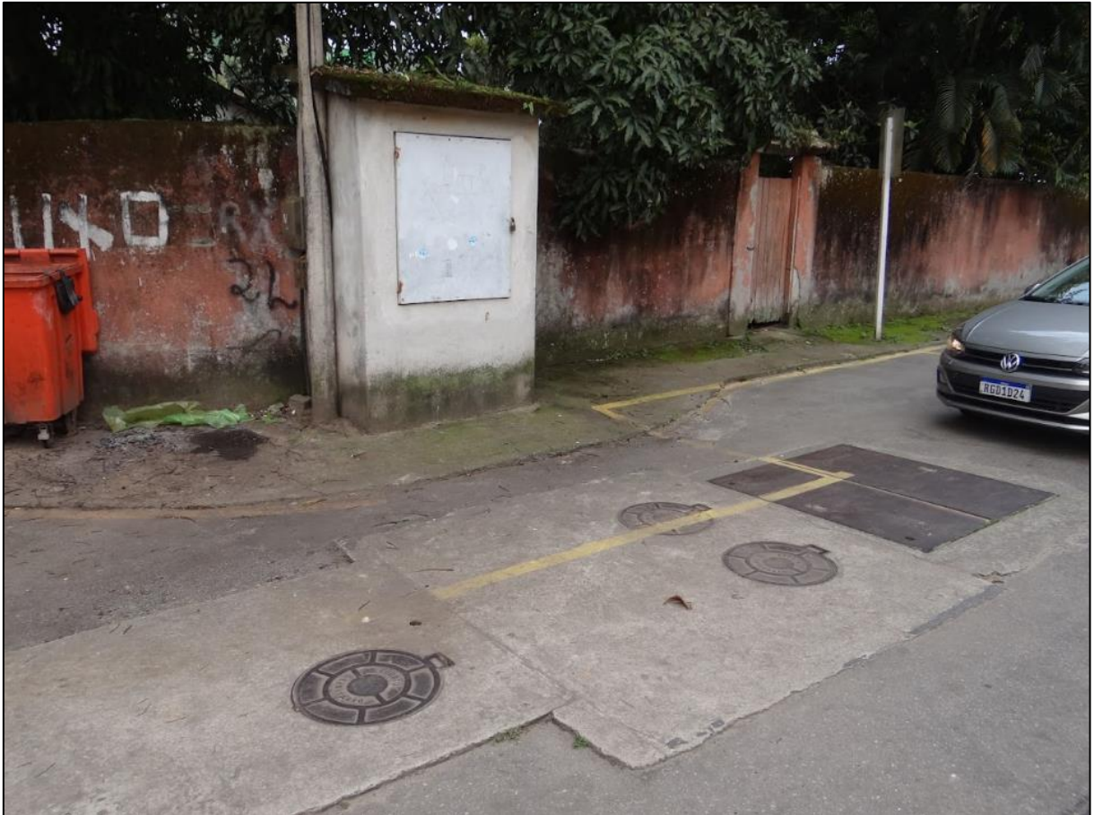
Figura 138 - EEE Frade - Rua dos Pinheiros
