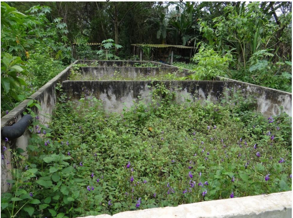
Figura 132 - Leito de Secagem
