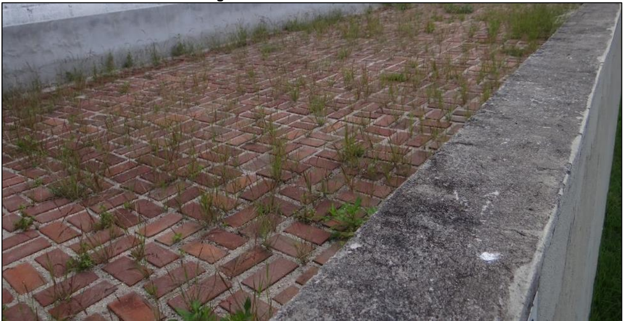
Figura 117 - Tratamento de Lodo
