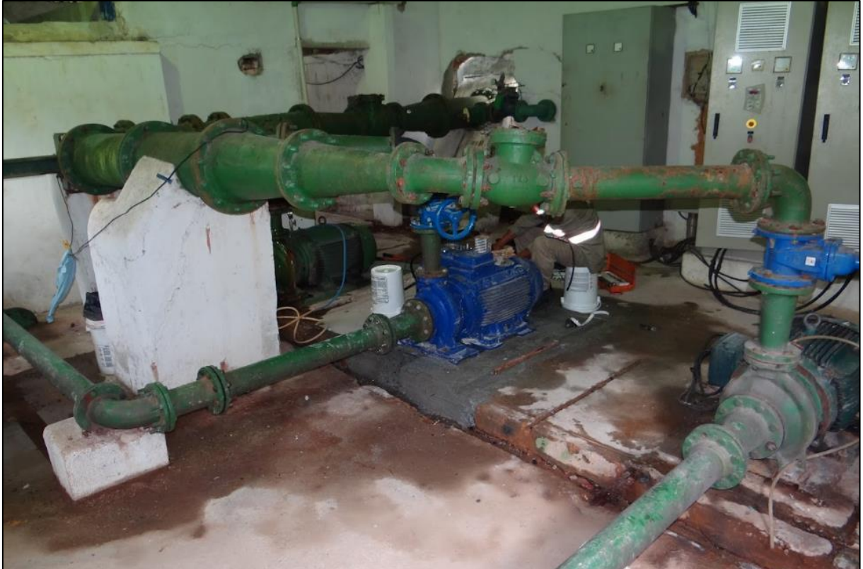
Figura 65 - Bombeadores 3, 4 e 5 do Complexo Banqueta
