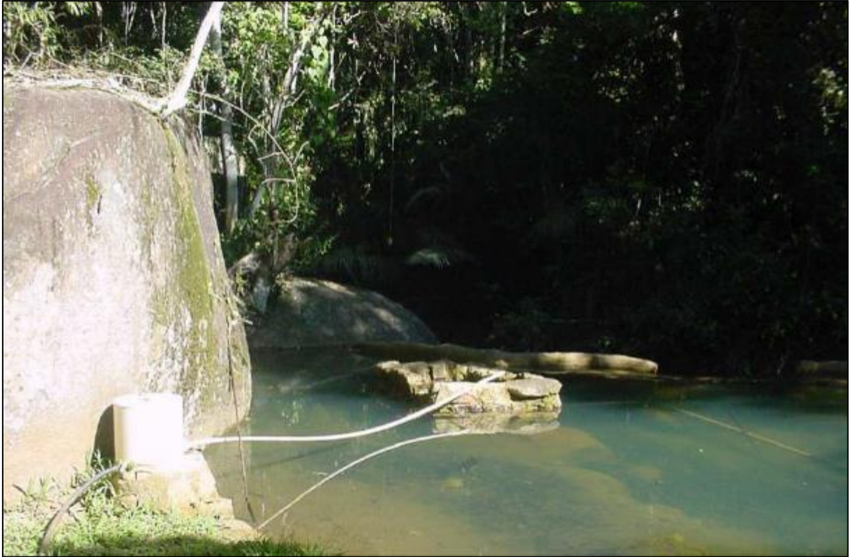
Figura 94 – Barragem Provetá 1 - Cafundó
