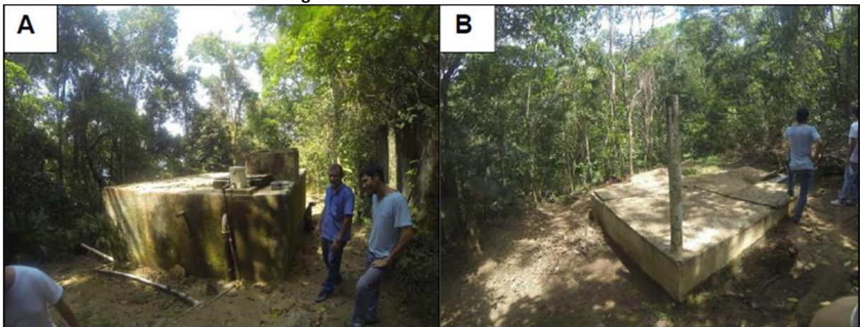
A: Caixa de areia intermediária; B: Reservatório
