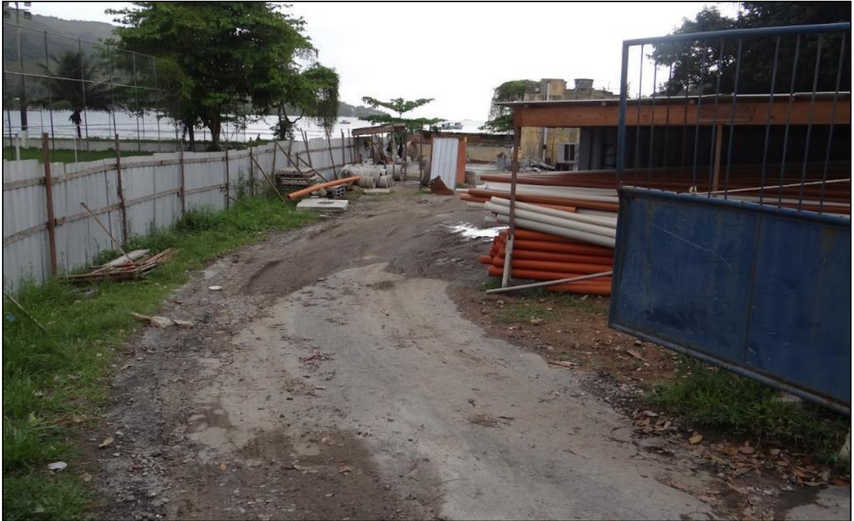
Figura 127 - Canteiro de Obras/ Área ETE Monsuaba
