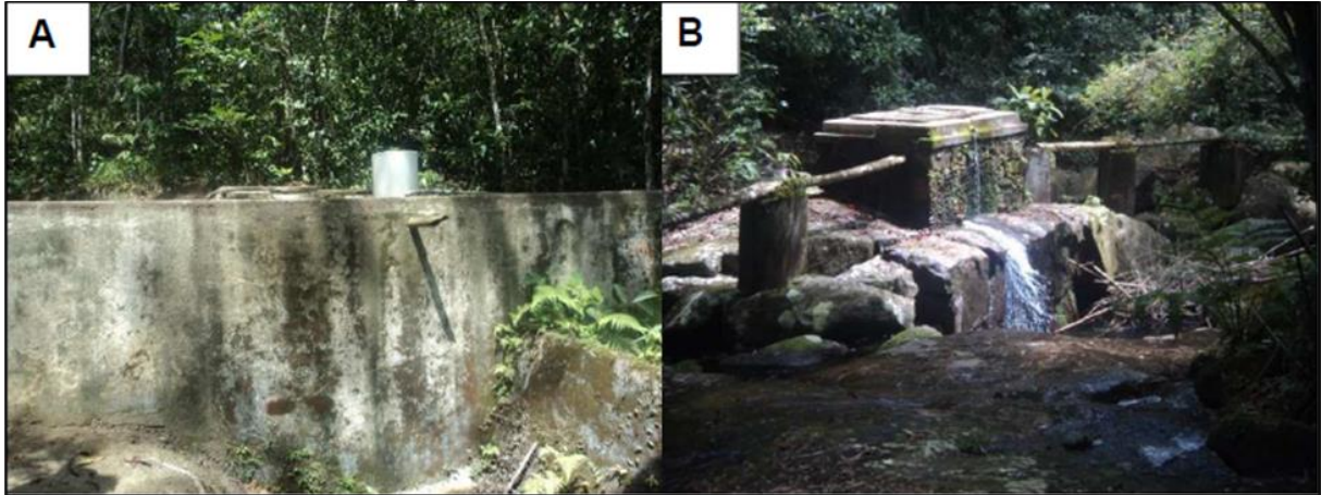
A: Detalhe do reservatório; B: Vista do entorno.
