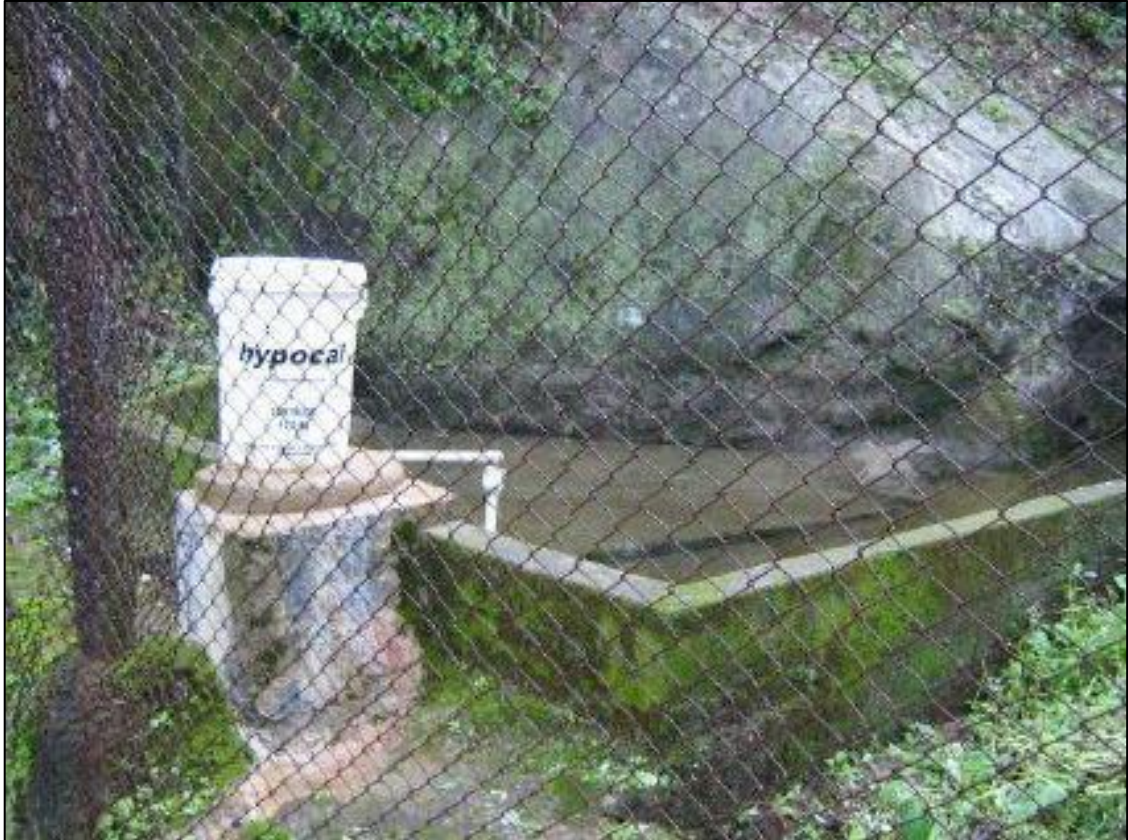
Figura 74 – Barragem de acumulação Toca do Morcego
