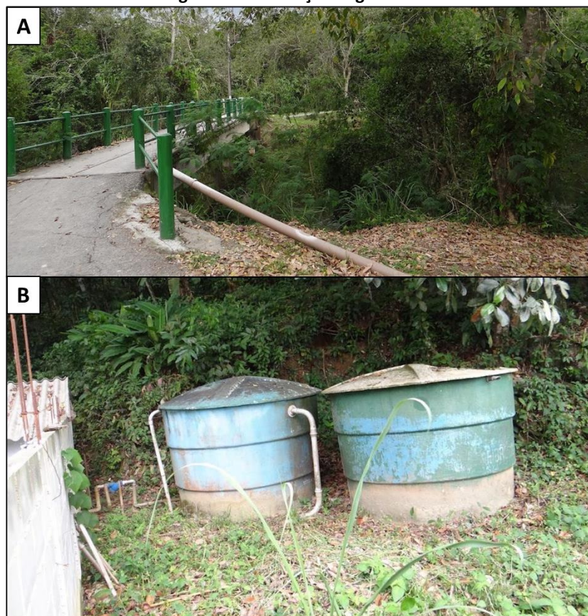
Figura 32 - Instalações Água Santa
