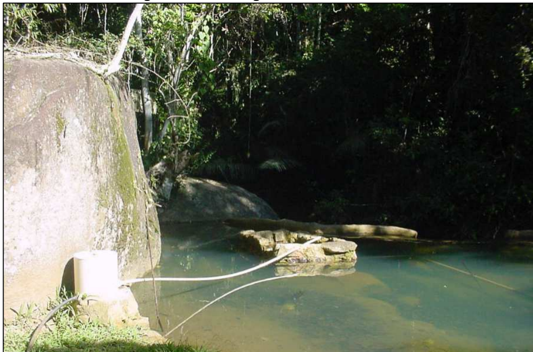
Figura 15.68. Barragem Provetá 1 - Cafundó
