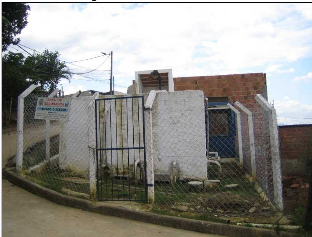
Figura 15.10. Reservatório Constância I
