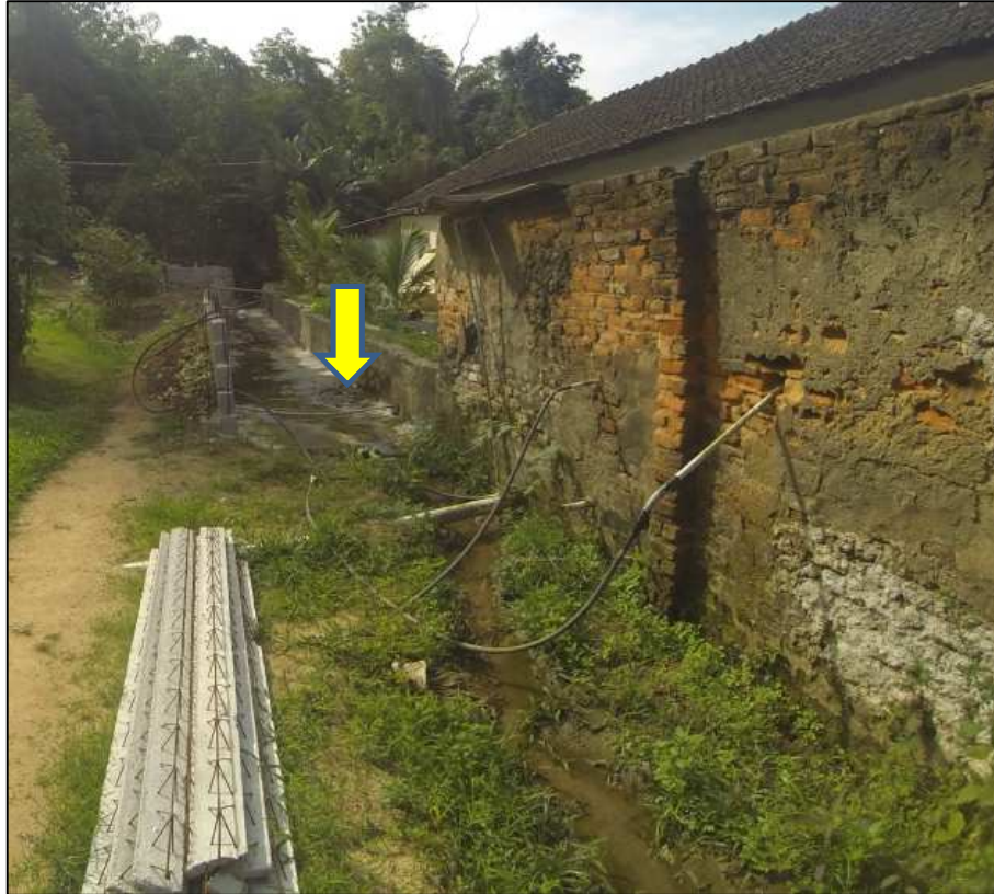
Figura 28.31. Rede coletora de esgoto e lançamento irregular de efluente em corpo d'água.
