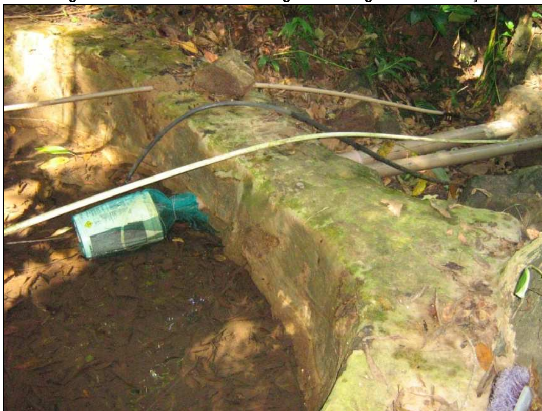
Figura 15.38. Crivo de tomada de água na barragem de acumulação
