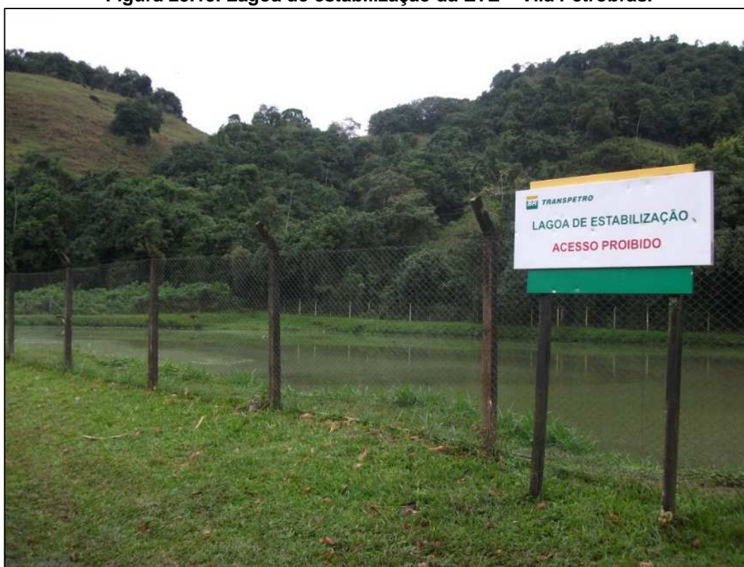
Figura 28.15. Lagoa de estabilização da ETE – Vila Petrobrás.
