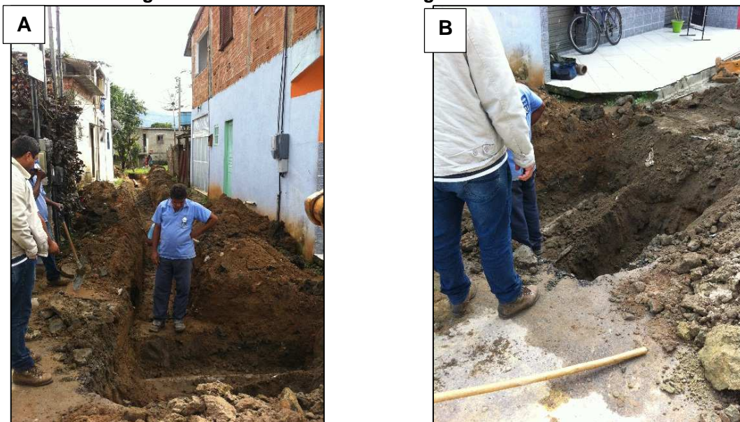
Figura 28.51. Obras na rede de esgoto do Sistema Bracuí
