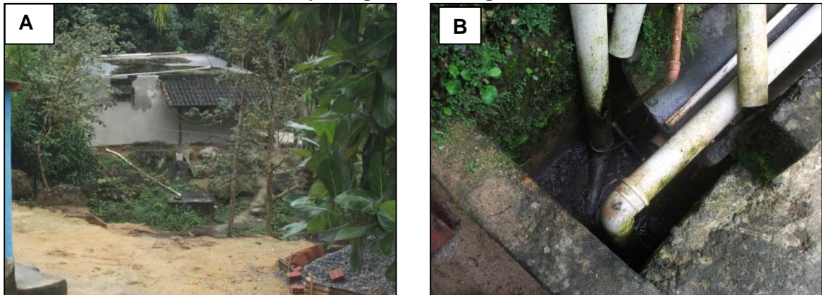
Figura 28.13. Fossa sumidouro individual e lançamento de esgoto “in natura” em caixa de passagem de drenagem.
