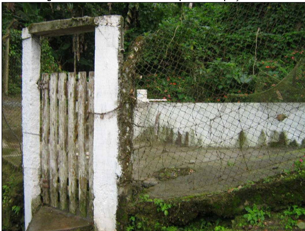
Figura 15.33. Portão e cercamento do ponto de Captação Júlia.
