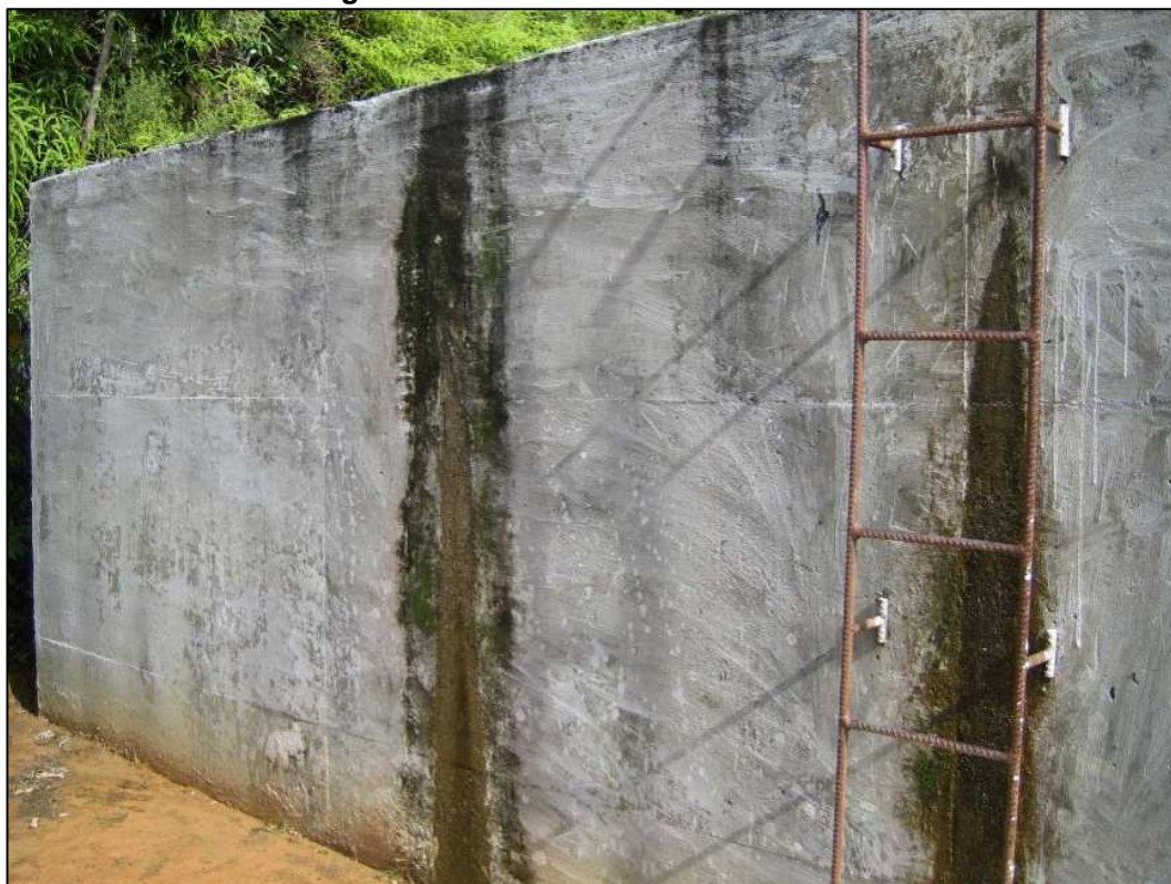
Figura 15.11. Reservatório Constância II
