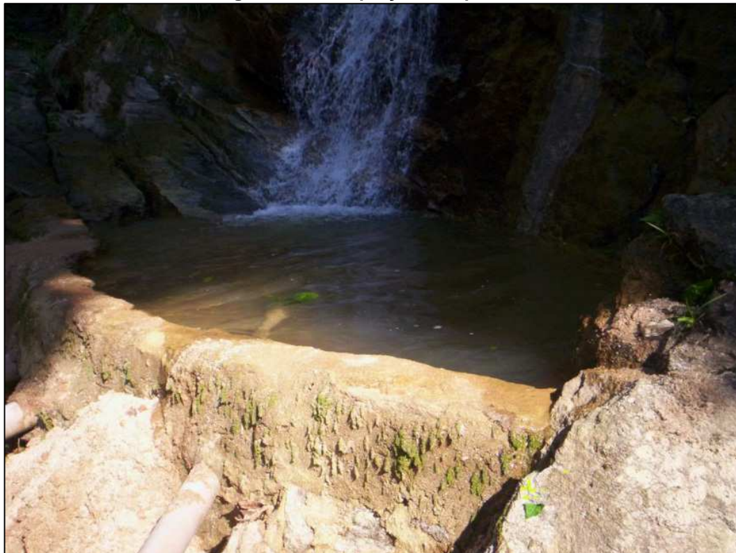
Figura 15.78. Captação Campo Belo
