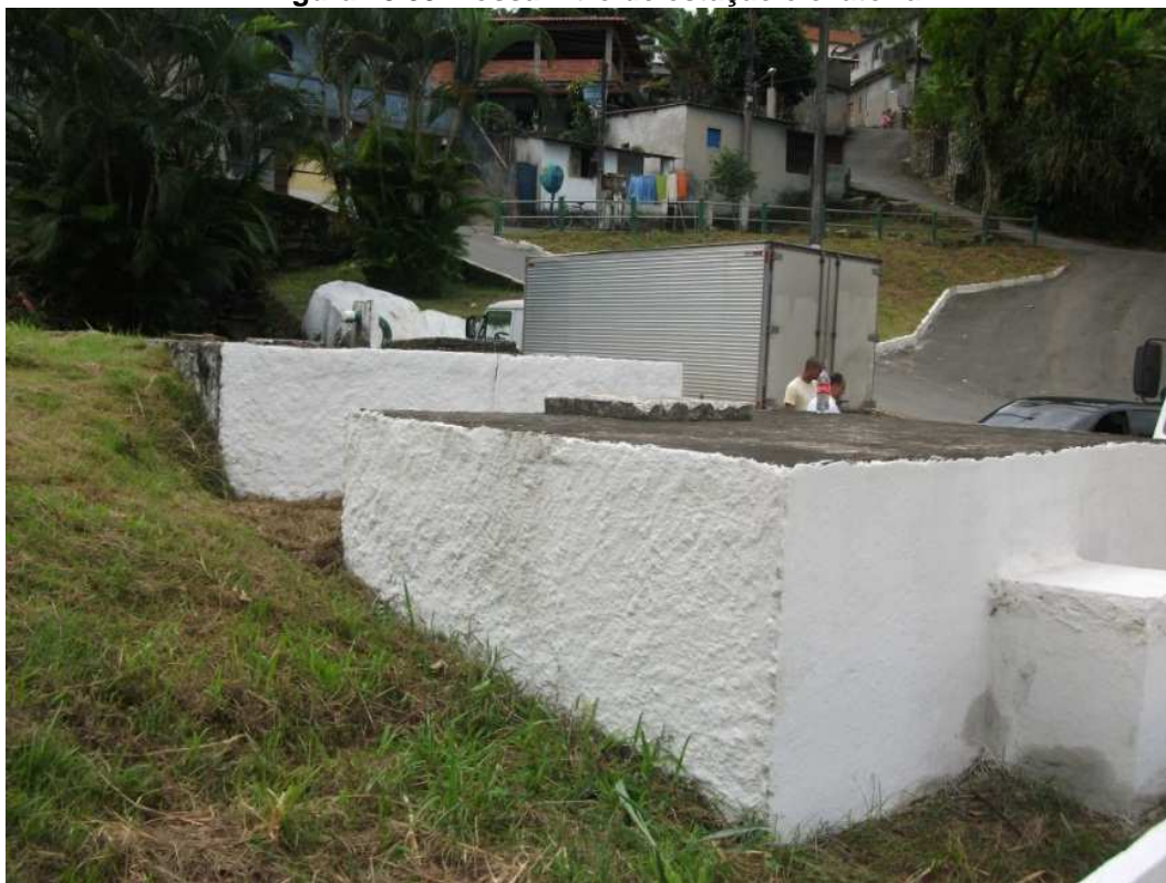
Figura 28.59. Fossa filtro de estação elevatória
