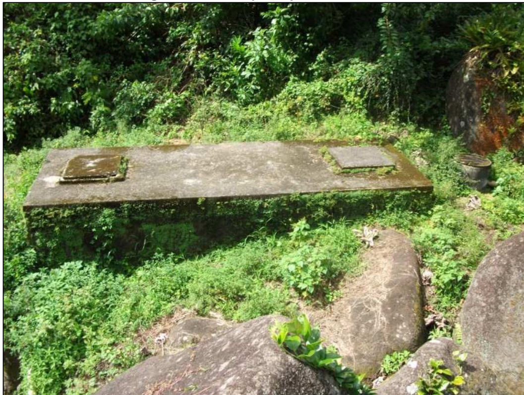
Figura 28.58. Tanque Séptico do sistema
