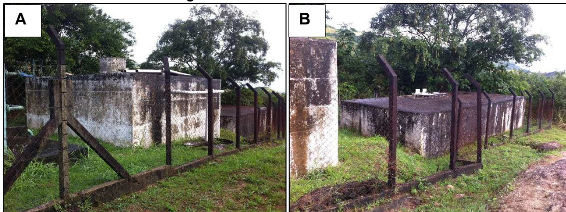
Figura 15.50. Reservatório Vai Quem Quer
