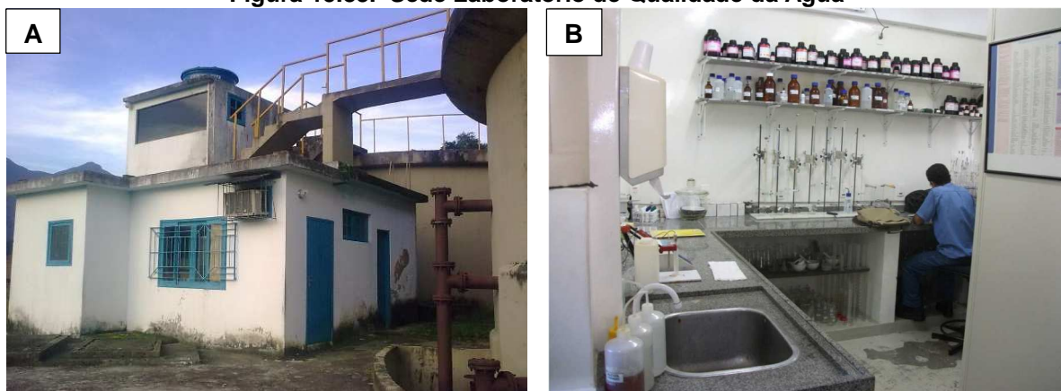
Figura 15.83. Sede Laboratório de Qualidade da Água
