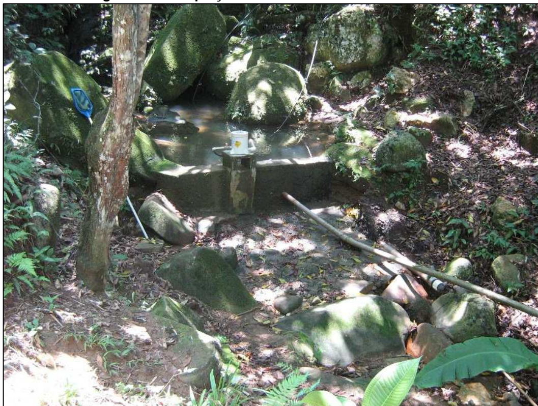
Figura 15.53. Captação e Tratamento do Sistema Paraíso
