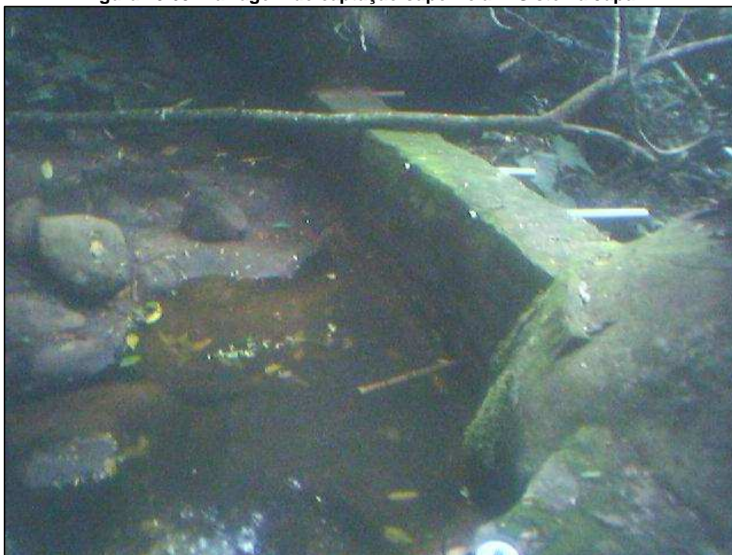
Figura 15.65. Barragem de captação superficial – Sistema Japariz.
