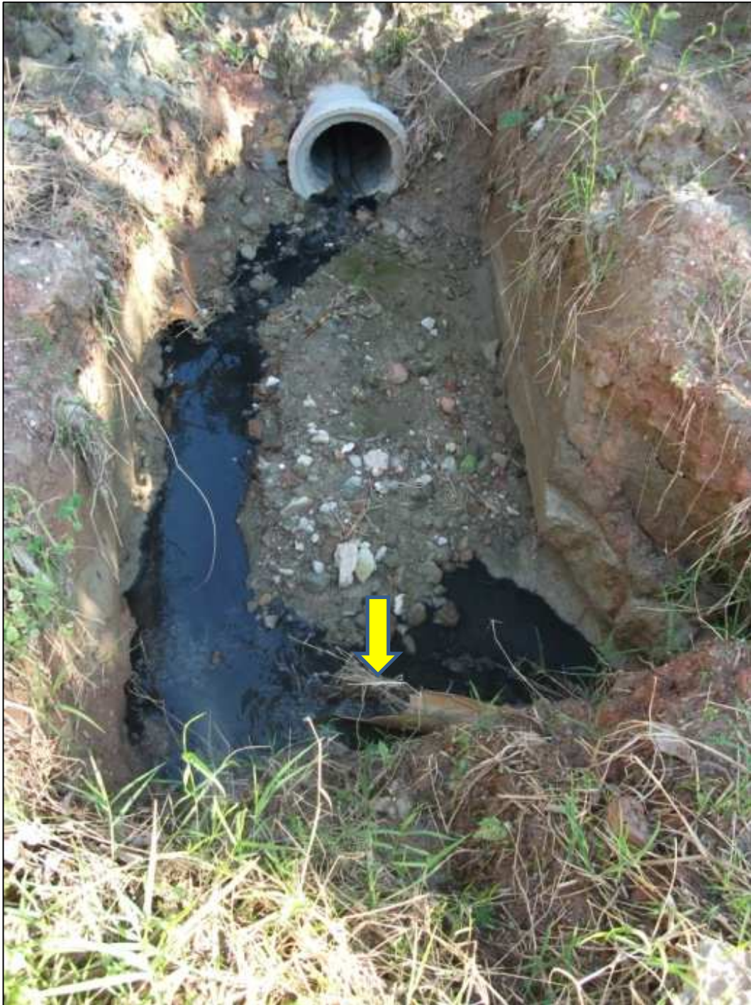
Figura 28.20. Exemplo de efluente da fossa filtro encaminhado à rede de drenagem pluvial.
