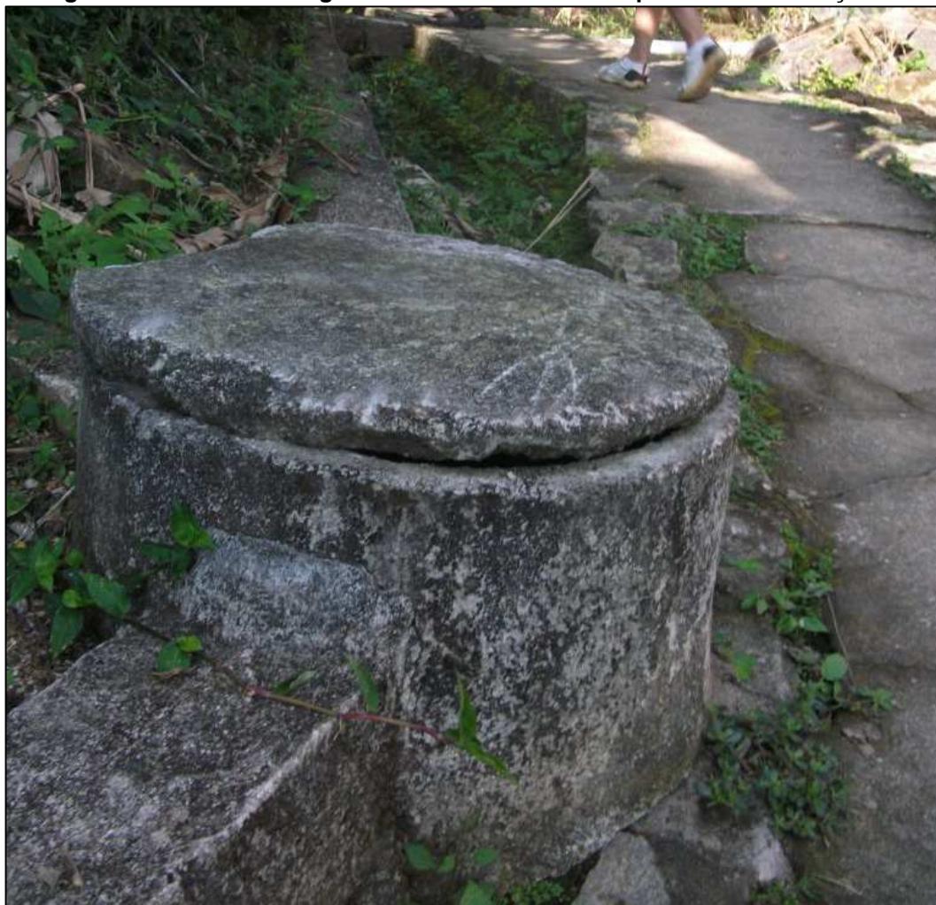
Figura 28.29. Rede de esgotamento sanitário e PV implantados em Araçatiba.
