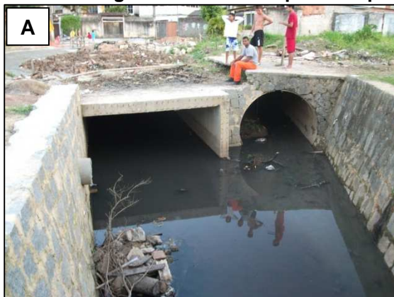
Figura 28.23. Canais pluviais que recebem efluente doméstico in natura.
