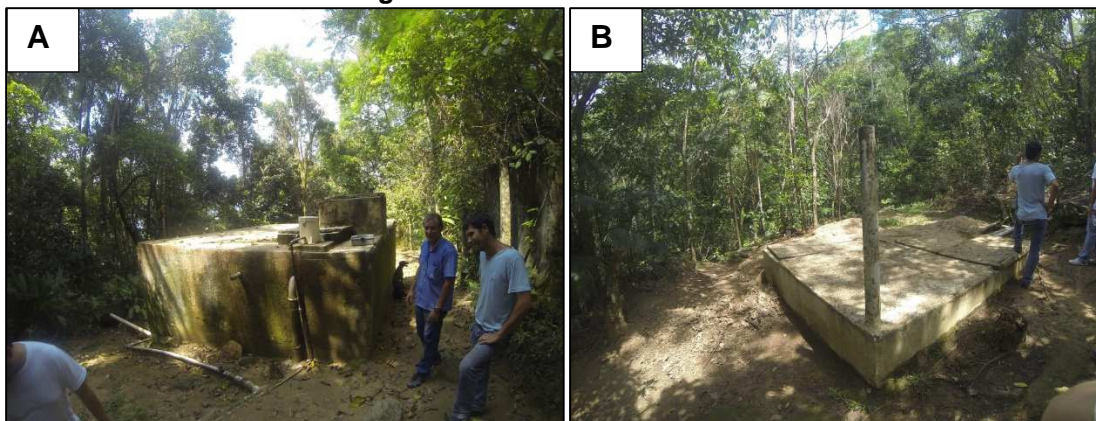
Figura 15.59. Reservatório da Encrenca.
