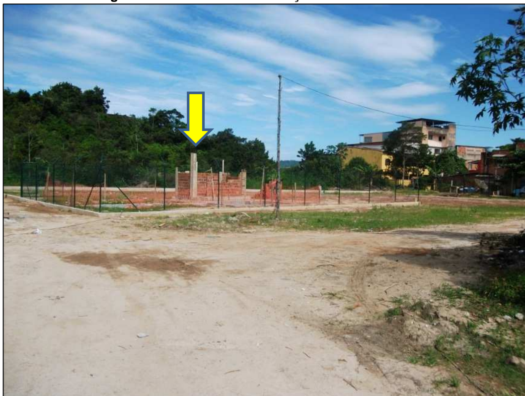
Figura 28.48. Obras de construção de ETE RAFA LAB
