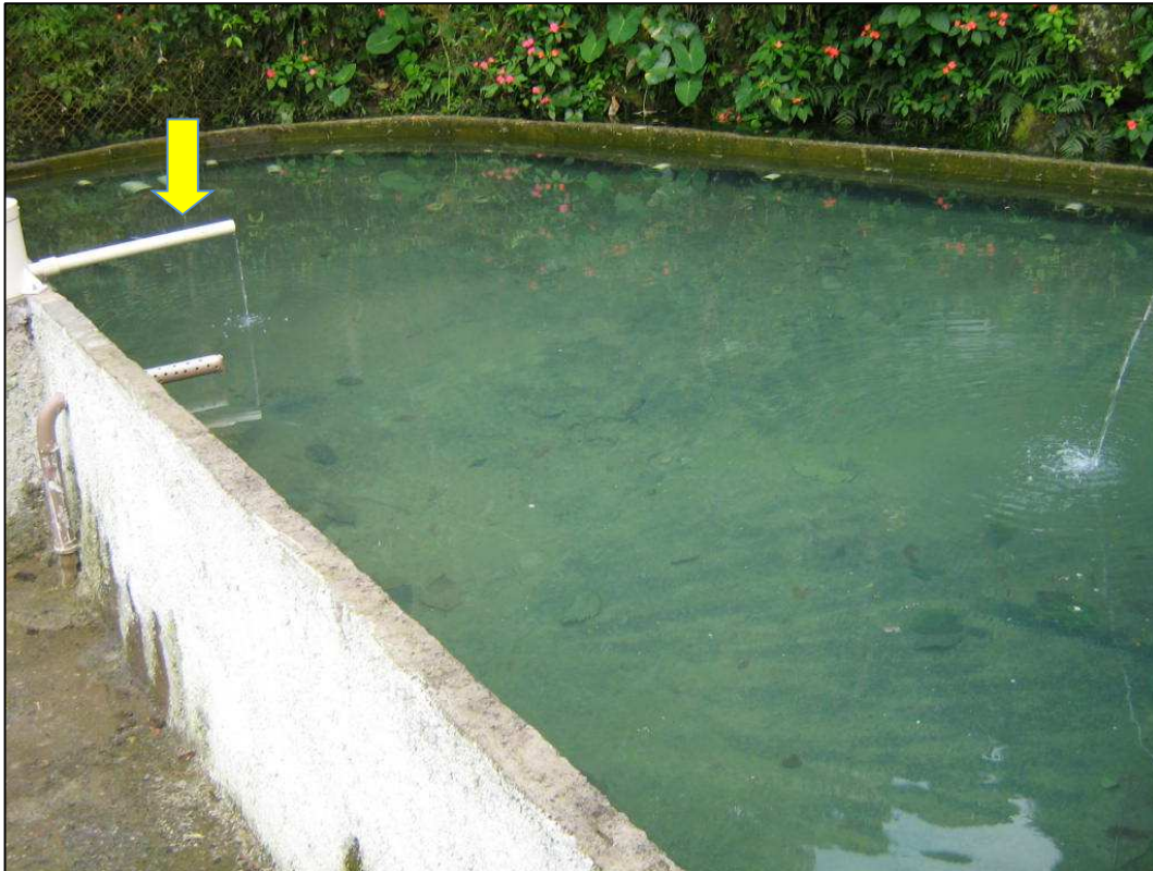
Figura 15.34. Barragem de acumulação e adição de hipoclorito de cálcio.
