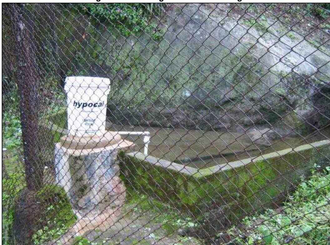
Figura 14.1. Barragem Toca do Morcego
