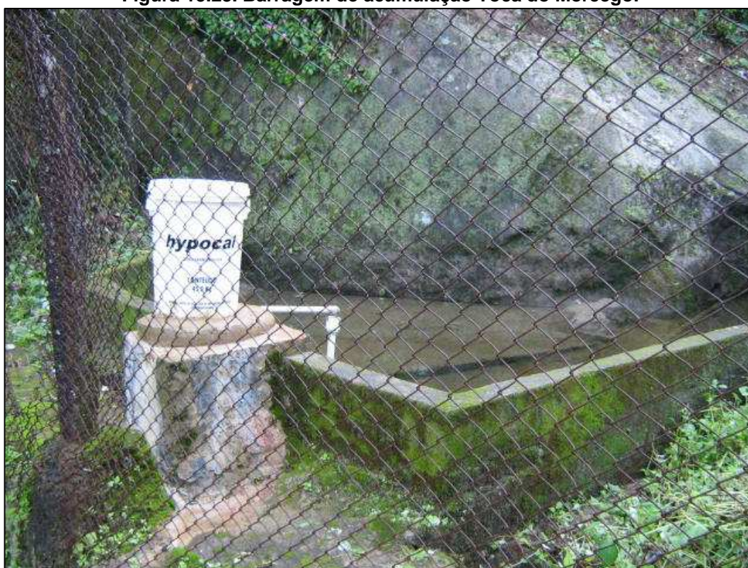
Figura 15.23. Barragem de acumulação Toca do Morcego.
