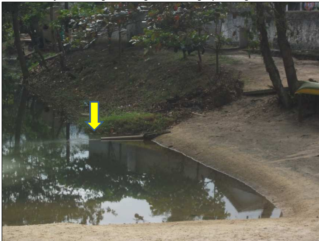
Figura 28.37. Lançamento irregular de esgoto em córrego que deságua na Praia de Provetá.
