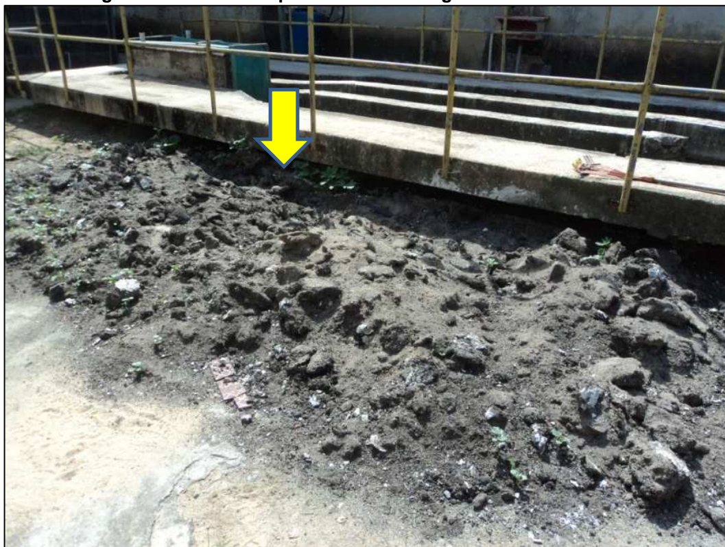
Figura 28.43. Lodo disposto em local irregular – ETE Vila Abraão.
