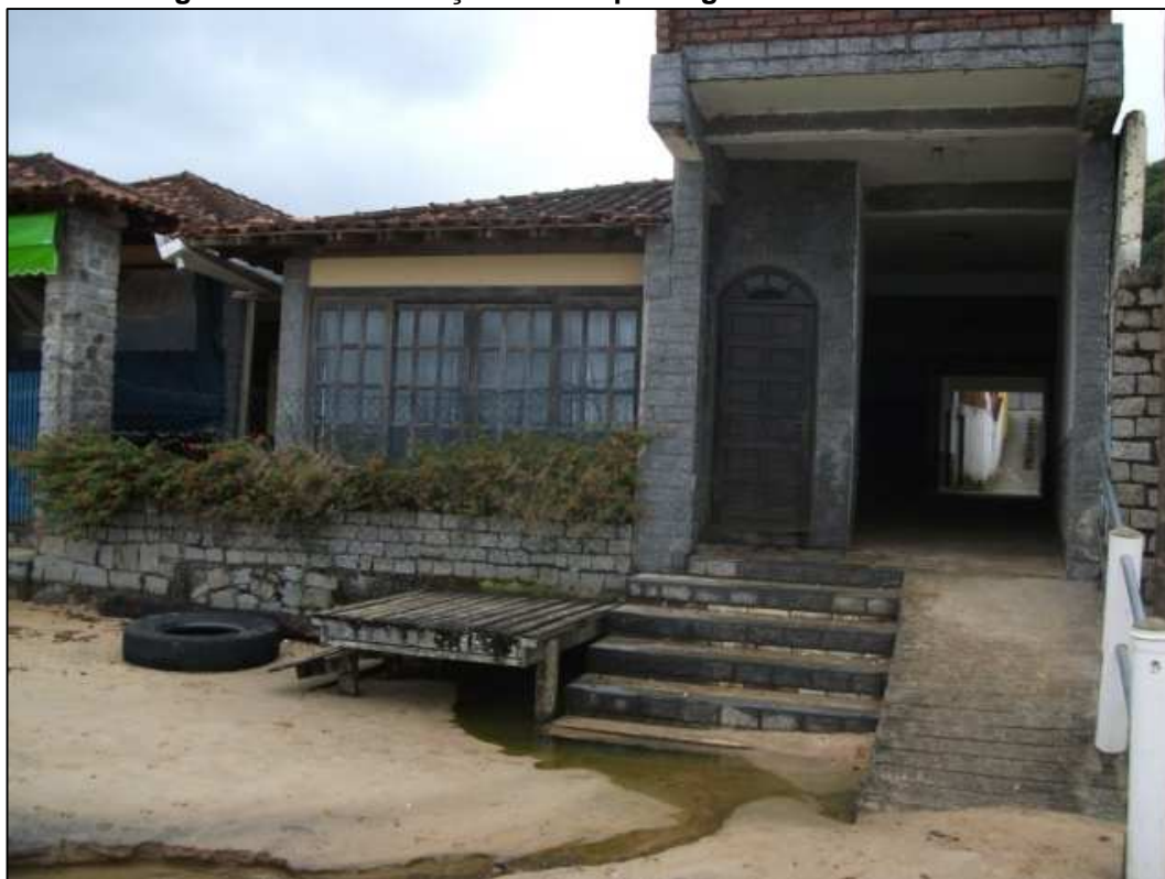
Figura 28.12. Construção sob corpo d'água na Praia de Biscaia.
