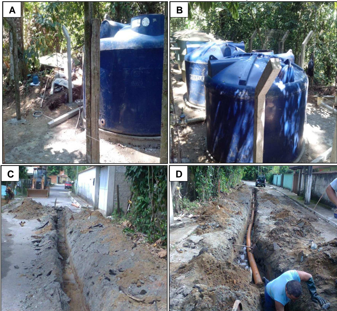
Figura 13.2. Reservatório no Bairro Bonfim e ampliação da rede.
