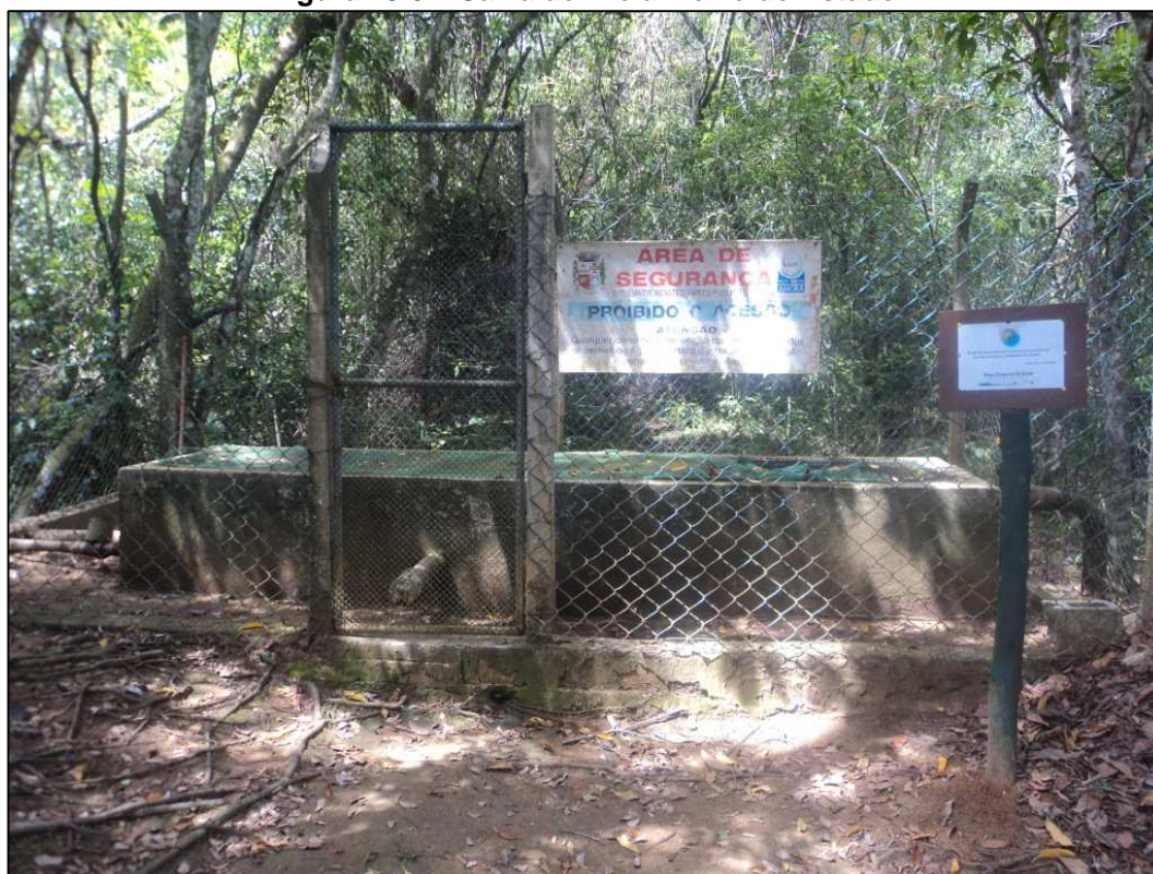
Figura 15.62. Caixa de Areia Morro do Estado.
