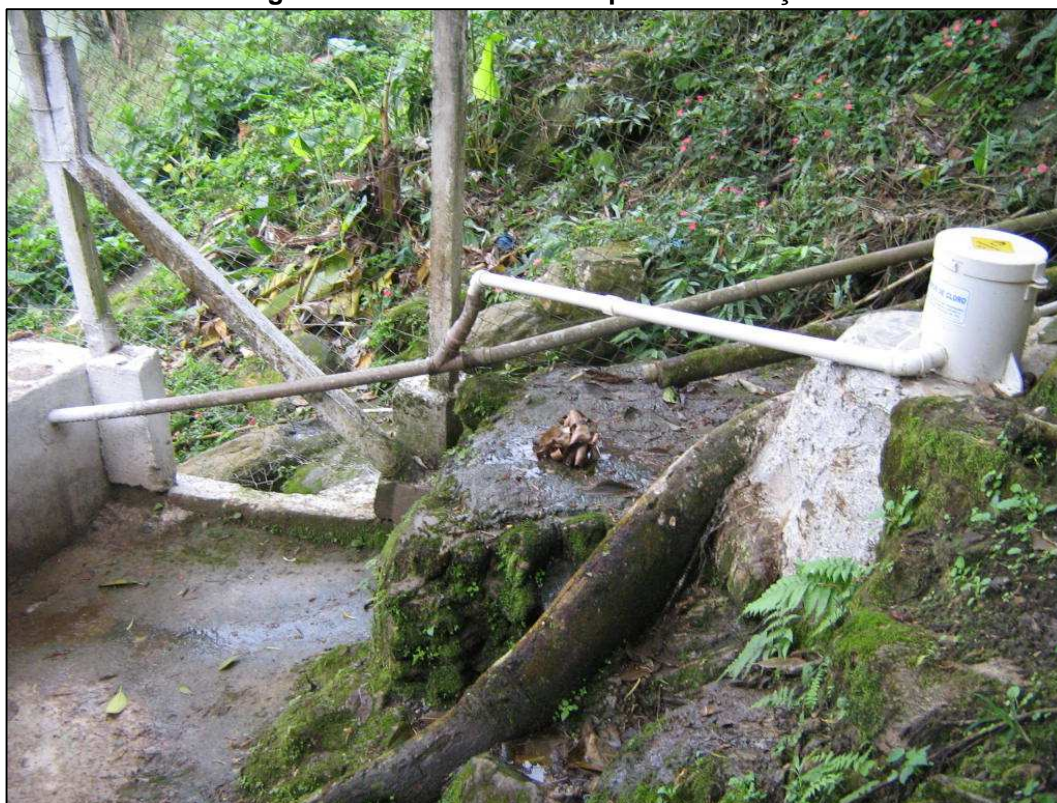
Figura 15.30. Sistema de simples desinfecção.
