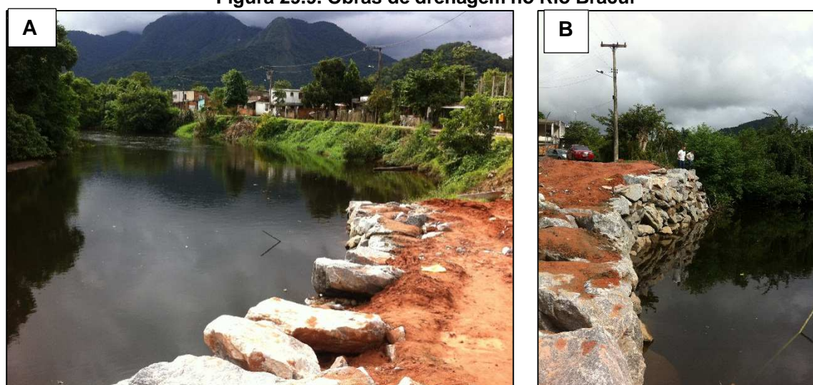
Figura 29.9. Obras de drenagem no Rio Bracuí
