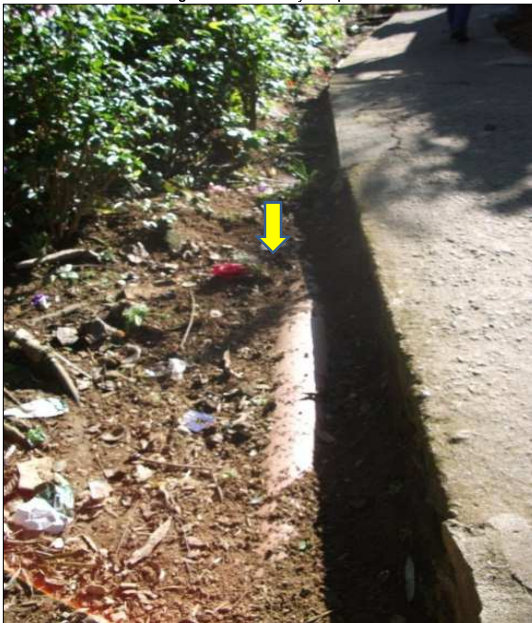
Figura 28.72. Tubulação exposta
