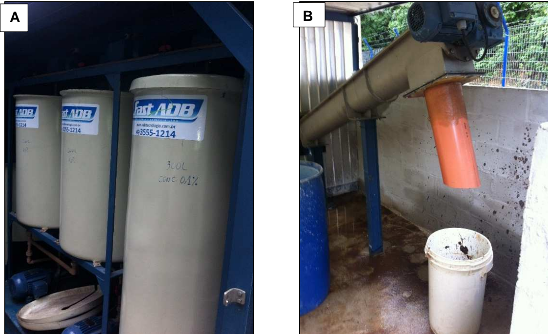
Figura 28.67 – ETE compacta para auxílio do tratamento.
