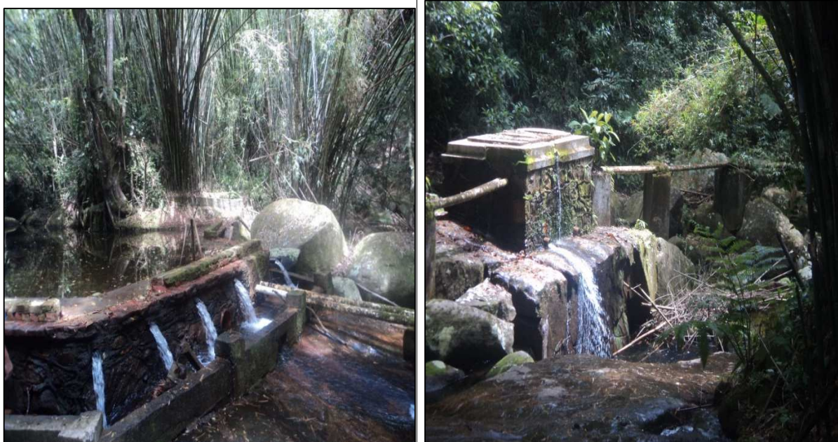
Figura 3.28. Captação do Estado – Abrão/Ilha Grande – Angra dos Reis.
