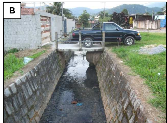
Figura 28.23. Canais pluviais que recebem efluente doméstico in natura.
