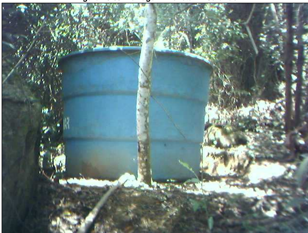
Figura 15.69. Barragem Provetá 1 - Cafundó
