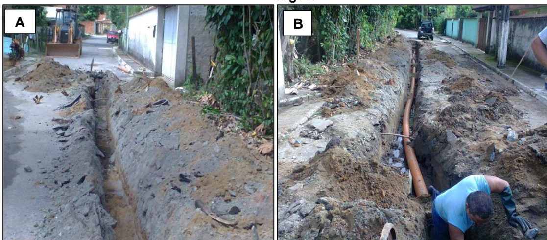
Figura 26.1. Construção e instalação de reservatório no Bairro Bonfim e ampliação da rede de esgoto.
