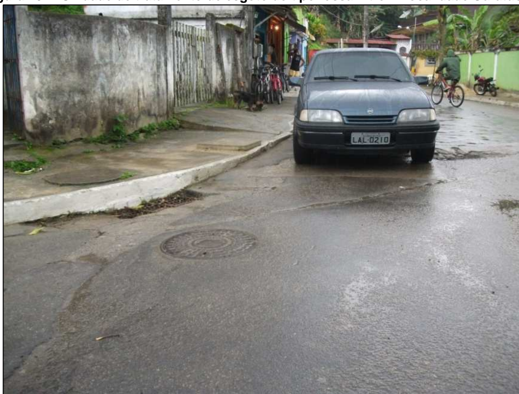
Figura 28.7. Unidade de tratamento de esgoto do tipo fossa filtro – Localidade Garatucaia.
