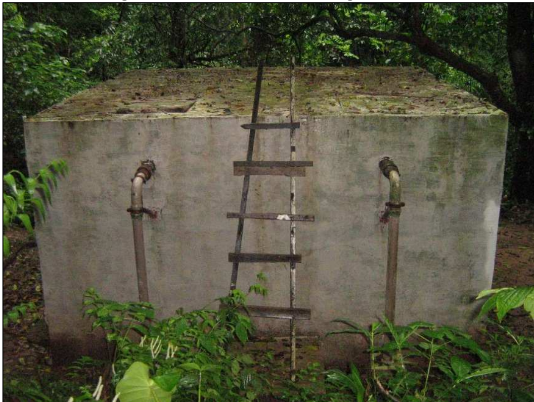
Figura 15.48. Reservatório Sistema Água Santa.
