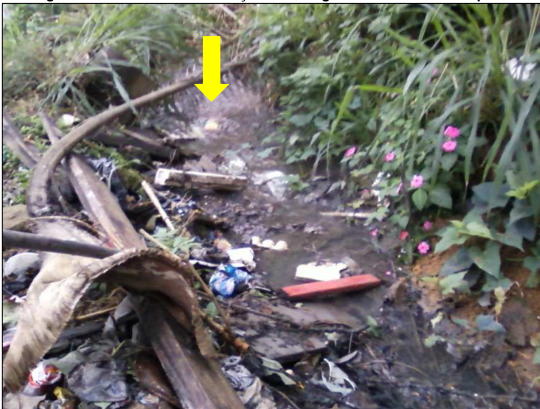
Figura 28.64 – Lambicada – Lançamento irregular e encanamento exposto
