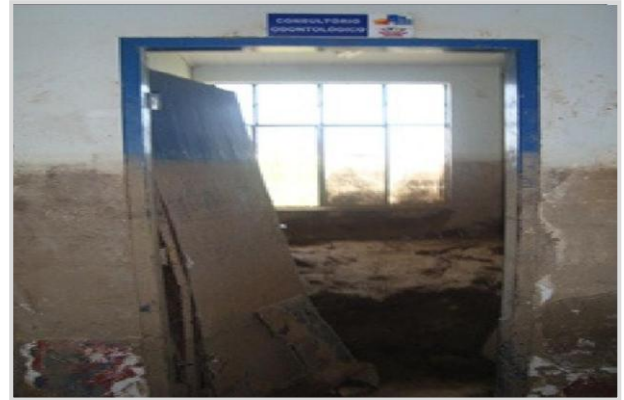
Área parcial da parte interna da UBS de Cujubim. Foto: CGU - Relatório de Fiscalização nº 201408699
