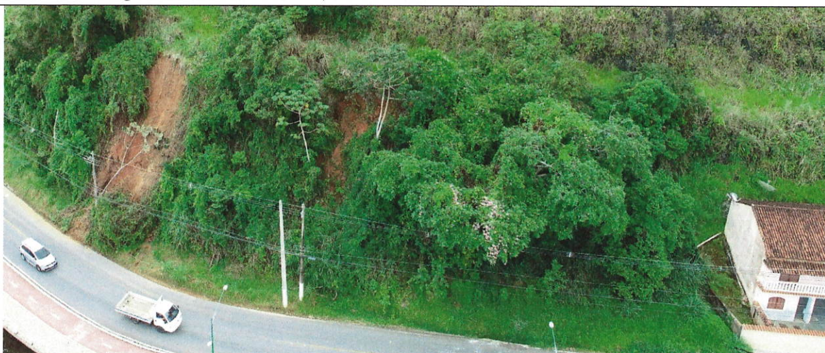
Fotos 06: Vista com destaque para cicatriz de escorregamento indicando a possibilidade de ruptura do solo, podendo avançar atingindo residência, poste público e resultar em bloqueio do acesso à Colégio Naval, foto SMA de 27/11/2018.
