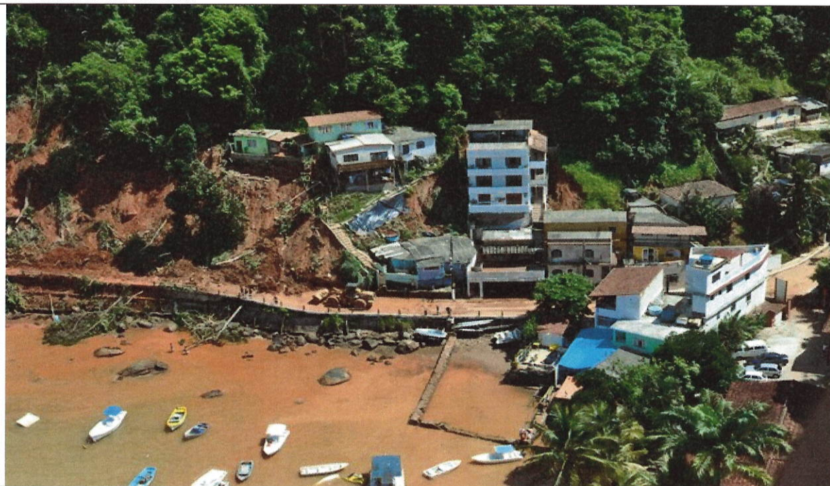
Foto 04: Encosta do Bonfim após ocorrência de 2010, foto SMA de janeiro de 2010.
