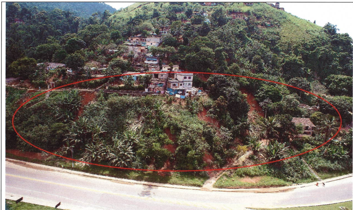
Foto 10: Vista geral encosta do Monte Castelo R:11.
