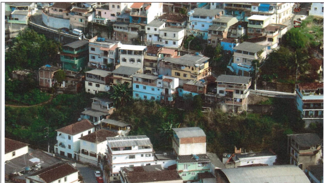
Foto 11: Vista geral encosta do Morro da Carioca - Centro.
