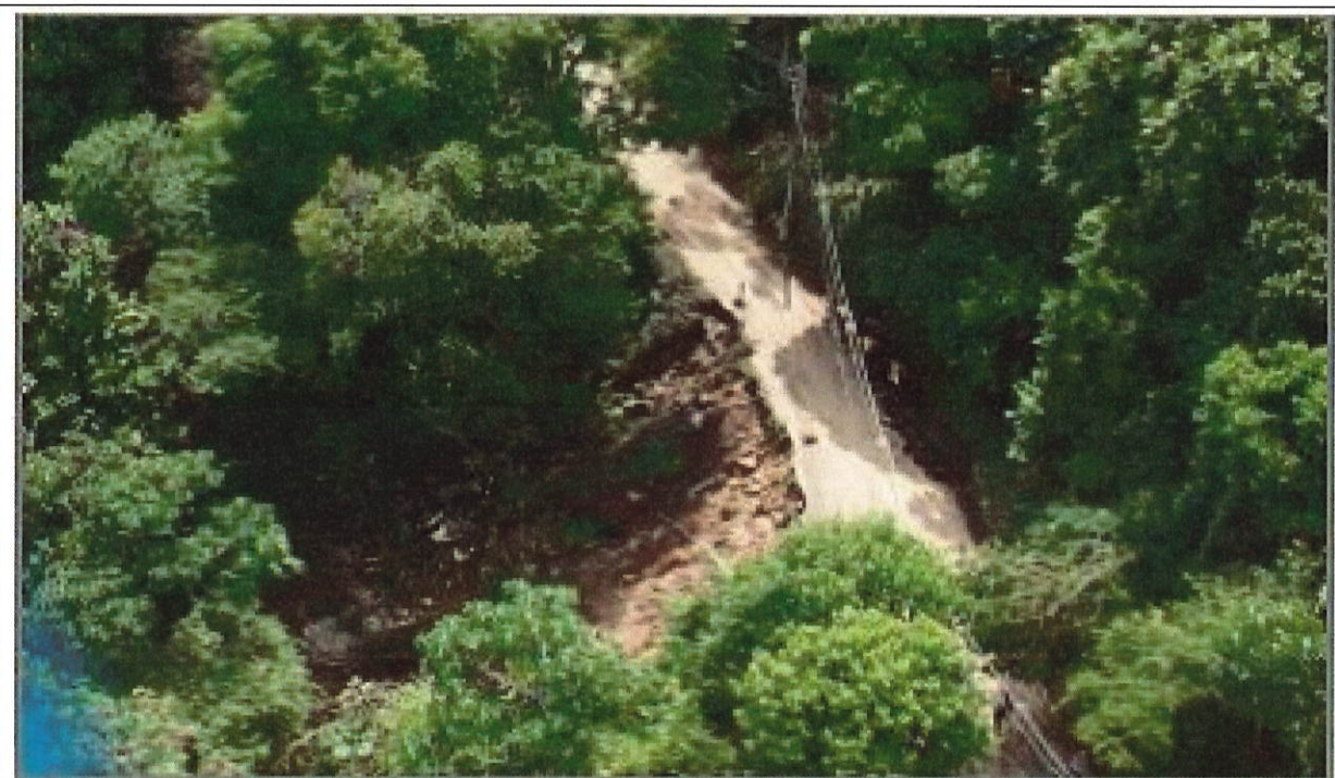
Fotos 23: Vista geral encosta do Retiro Tanguá.
