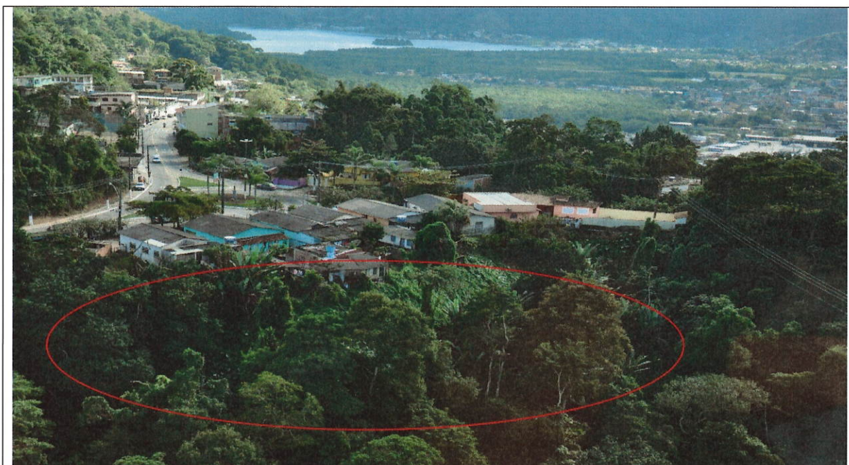
Foto 13: Vista geral encosta do Morro da Cruz.
