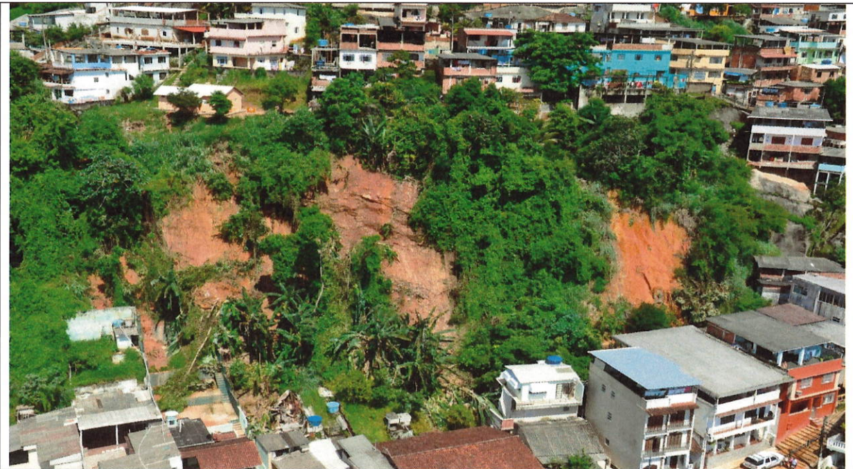
Foto 17: Vista geral encosta do Morro S. Ant. e Carioca.
