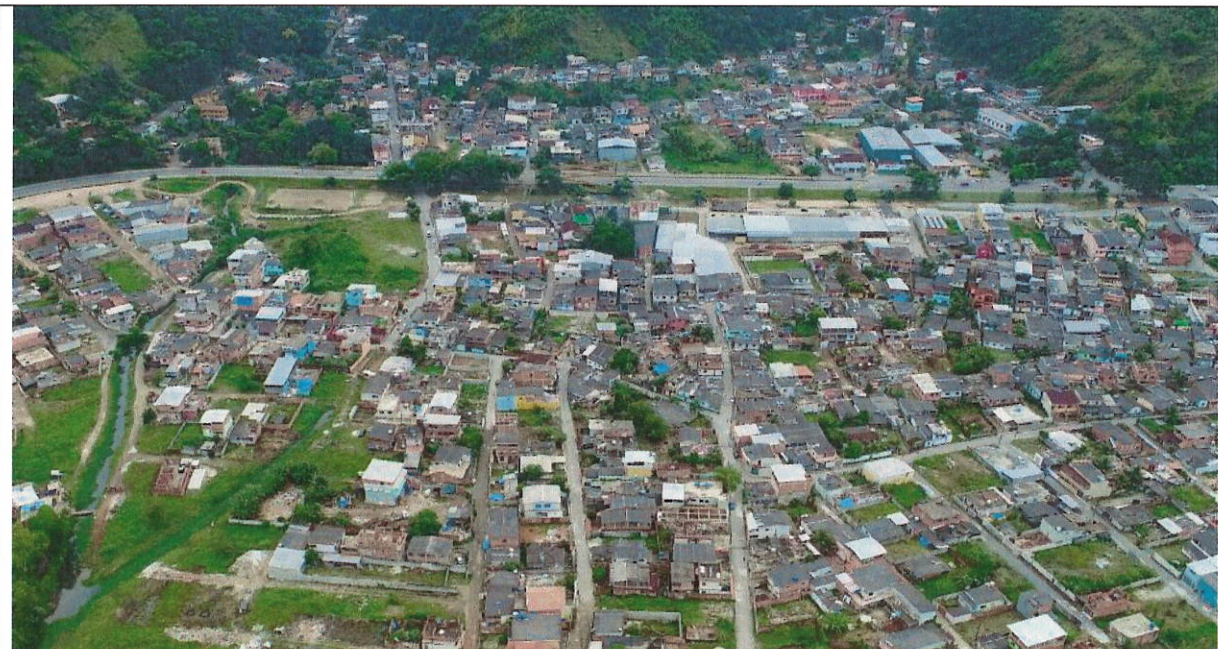
Fotos 24: Vista geral encosta da Santa Rita.
