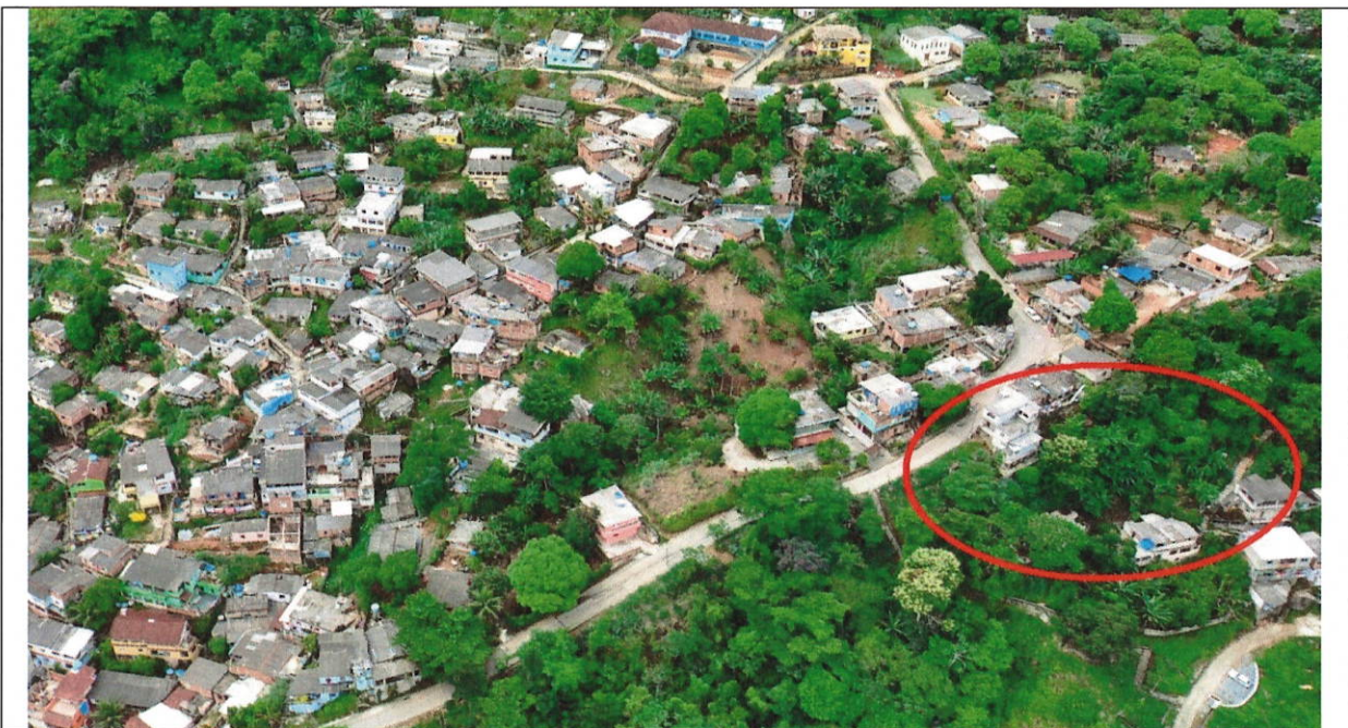
Foto 09: Vista geral encosta do Monte Castelo R.17.
