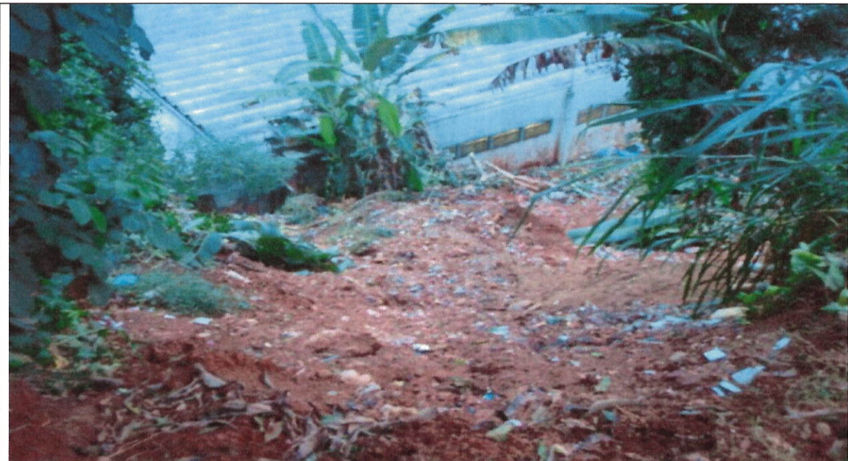
Foto 04: Vista geral encosta Campo Belo.
