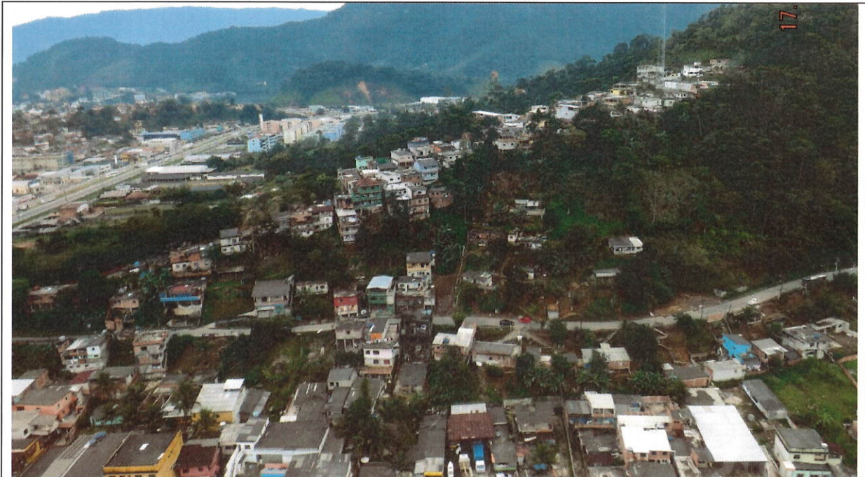
Foto 19: Vista geral encosta da Nova Angra.
