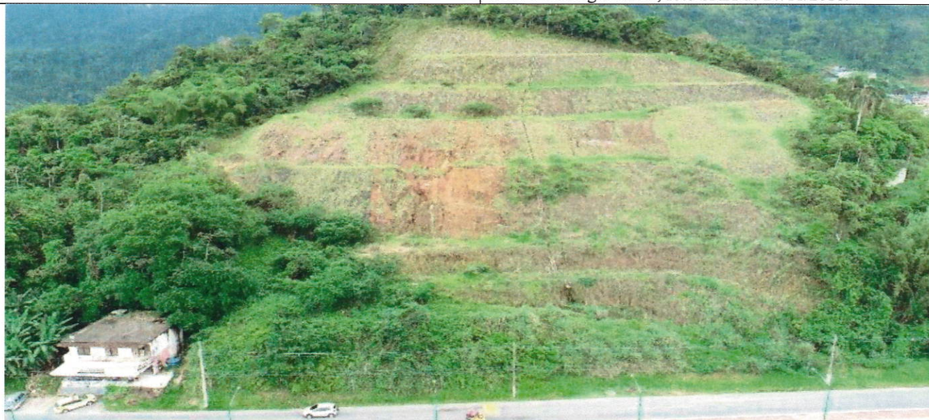
Fotos 07: Vista com destaque para cicatriz de erosão indicando a possibilidade de ruptura do solo, podendo avançar atingindo residência, poste público e resultar em bloqueio do acesso à Colégio Naval, foto SMA de 27/11/2018.
