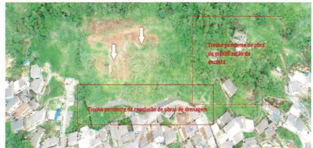
Fotos 09: Vista com destaque para o trecho pendente de conclusão das obras de contenção com o destaque das casas envolvidas e trecho com falta de drenagem das águas de chuva, foto SMA de 27/11/2018.
