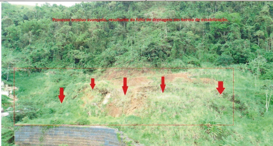
Fotos 10: Vista com destaque para o processo erosivo avançado mostrando a perda do serviço executado por falta das drenagens, foto SMA de 27/11/2018.
