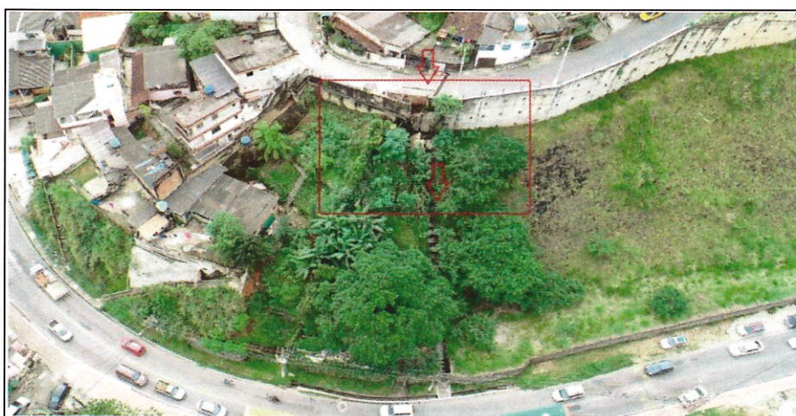
Foto 12: Vista geral encosta da glória II, foto SMA de 27/11/2018.
