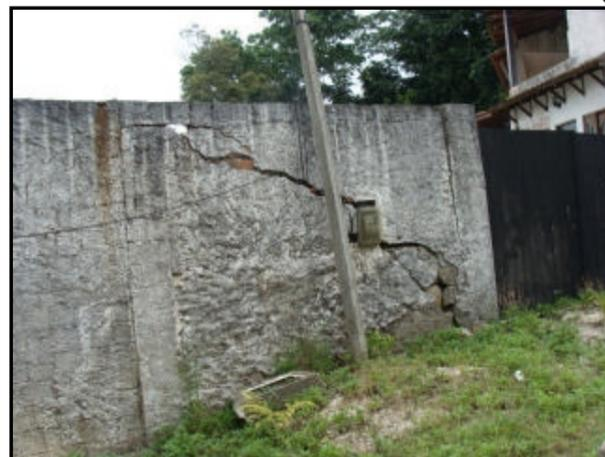
**Descrição:** Ocupação em encosta muito íngreme com risco remanescente de escorregamento planar. Presença de muros e estruturas com rachaduras, e degraus de abatimento.
