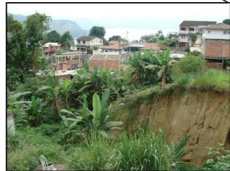
**Descrição:** Vale com ocupação desordenada com aterramento e edificações no talvegue da drenagem e encostas íngremes formadas por colúvios e depósito de talus com sucessão de corte aterro. Risco de escorregamento planar, rolamento de blocos e enxurradas.
