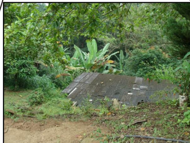
**Descrição:** Crista de morro alongado e estreito com ocupação no topo com risco remanescente de escorregamento planar instalado em 2010. Presença de solo residual muito friável com alta suscetibilidade a erosão.
