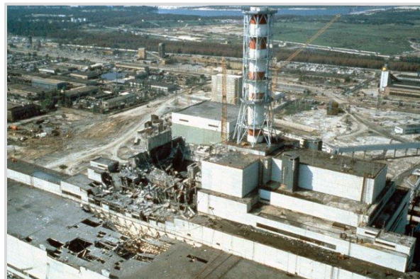
Prédio da usina de Chernobyl após a explosão Imagem: Laski Diffusion/Wojtek Laski/Getty Images/Hulton Archive
