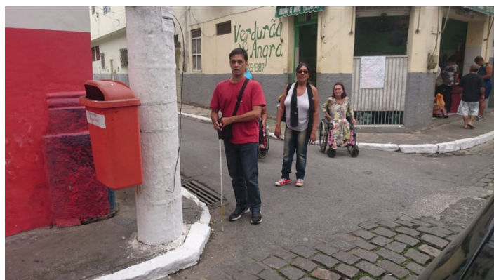
Calçada estreita, poste com lixeira no meio da mesma, impedindo o ir e vir.
